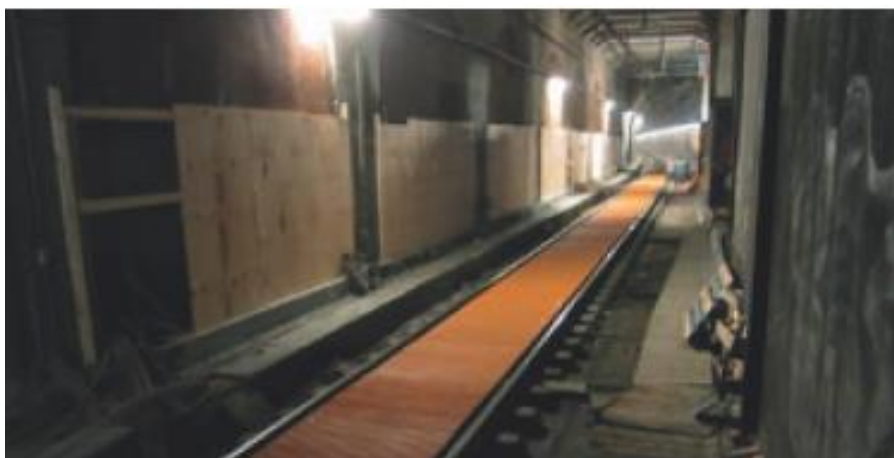
1.3 pav. Metro tunelio atnaujinimas Kopenhagoje, Danijoje (Ascione et al. 2016:13)
