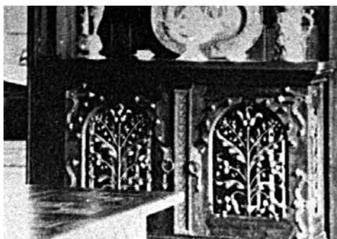
g) Rokškio valgomajame radiatoriai (3vnt.) buvo įrengti po servantais su azūrinėmis kalto metalo dūrelėmis, fot. nežinomas, XX a. I p.
