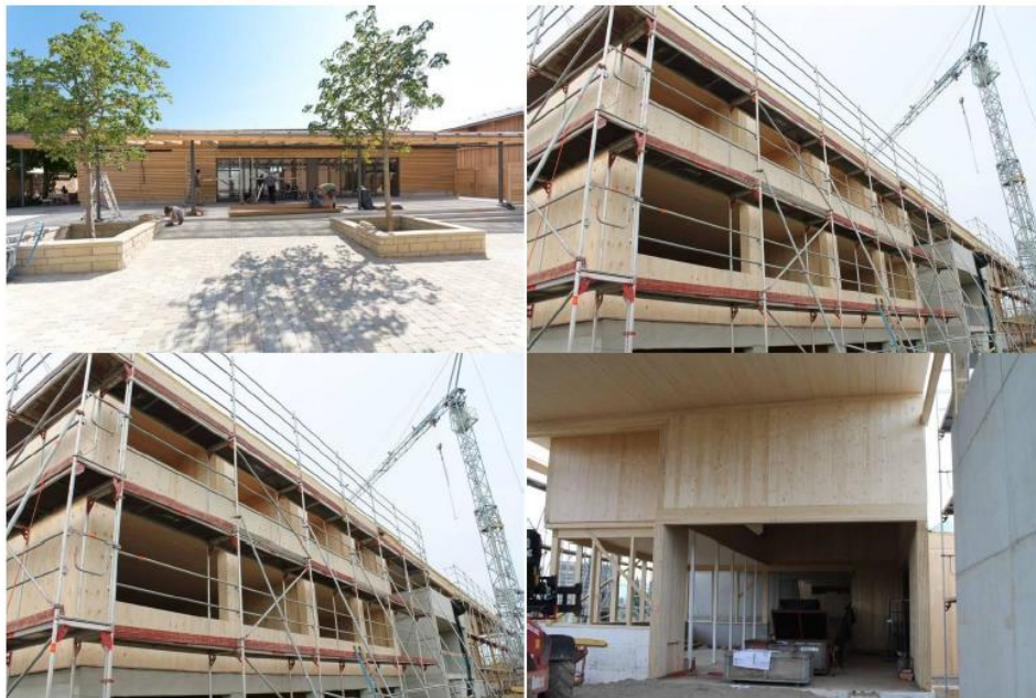
22 pav. Vyno gamykla pastatyta pagal Massiv-Holz-Mauer technologiją (Lysenko, 2018, p. 49)
