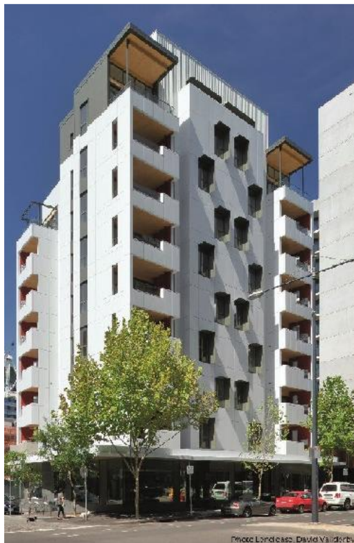
18 pav. „Forté“ 32 metrų aukščio daugiafunkcinis pastatas iš CLT plokščių (WSP, 2018)
