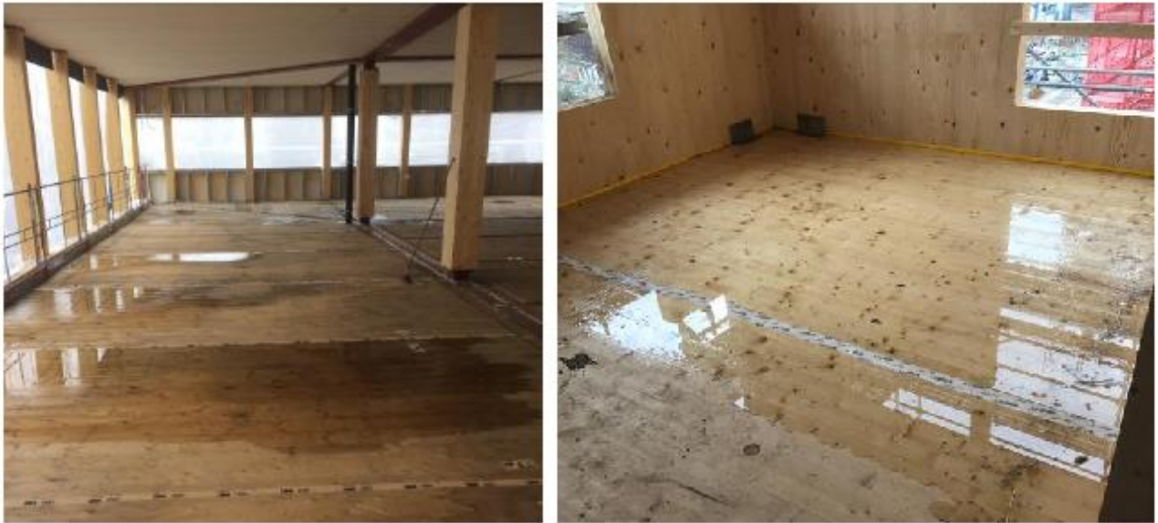
13 pav. Lietaus vandens prasiskverbimas per jungtis į patalpų vidų (Olsson, 2020, p.4)
