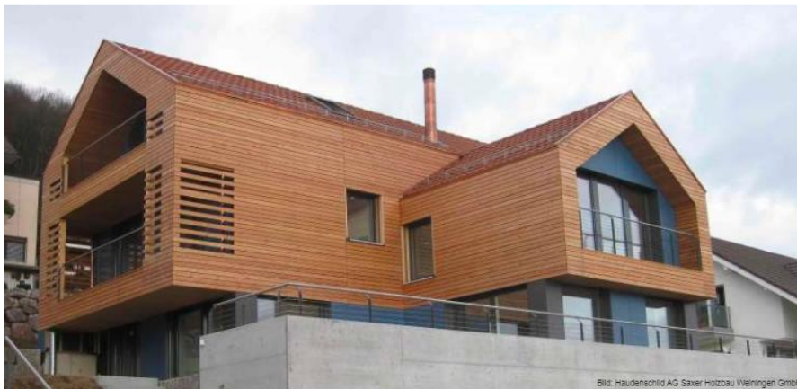
20 pav. Daugiaaukštis gyvenamasis namas pastatytas iš CLT plokščių (Natürlich wohnen ohne Leim und Chemie, 2018)
