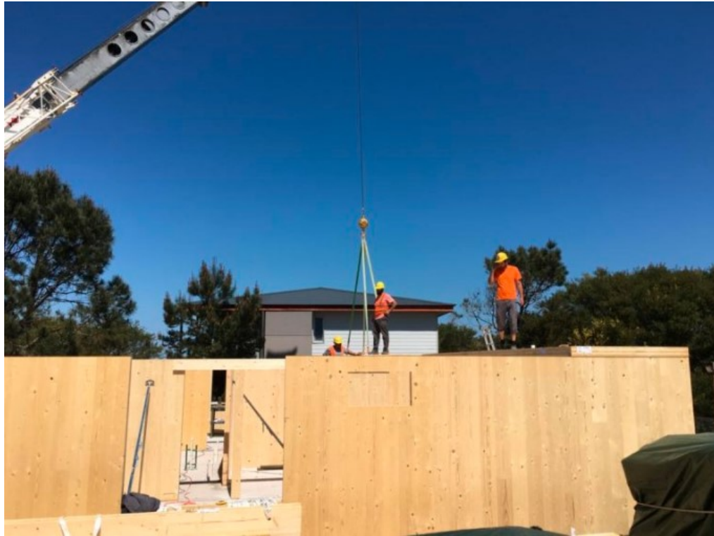
B priedas. CTL plokštės konstrukcinių elementų surinkimas statybvietėje (ENKEL, 2020)
