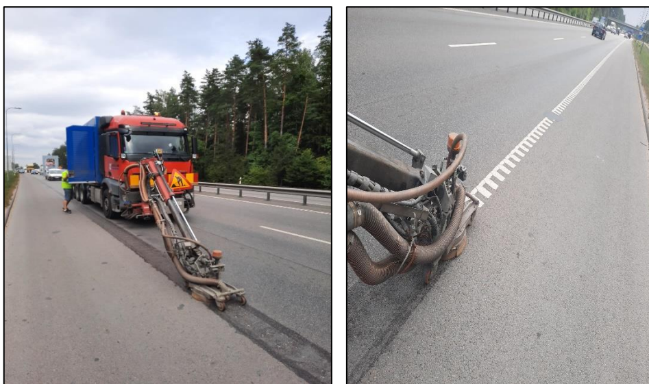
1.6 pav. Horizontaliojo ženklavimo naikinimas vandens čiurkšlės metodu kelyje A19 (autorius nuotraukos, 2020).
