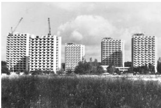
3.13 pav. Vilniaus „Saulėtekio“ akademinio miestelio bendrabučių grupė, archit. B. Krūminis, 1974–1980, A. Grinčelaičio nuotr., 1980, LCVA Fig. 3.13. “Saulėtekis” academic town dormitory group in Vilnius, arch. B. Krūminis, 1974–1980, photo by A. Grinčelaitis, 1980, LCVA
