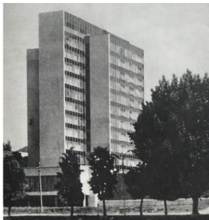
2.38 pav. Vandens ūkio ministerija Vilniuje, archit. V. Oleiničėna, 1973, Statyba ir architektūra , 1973
