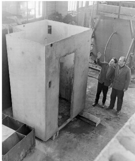
2.82 pav. Santechninės kabinos apžiūra Vilniaus g/b konstrukcijų gamykloje, M. Baranausko nuotr., 1963, LCVA
