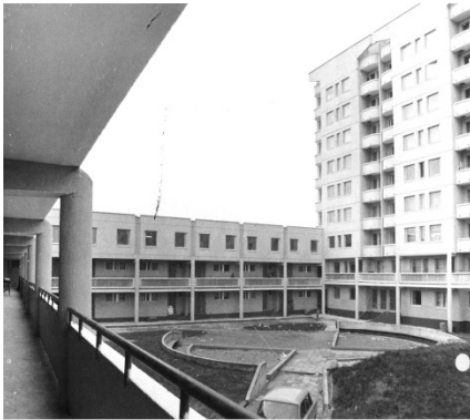
3.7 pav. Gatvės danguje Pašilaičių komplekse, archit. D. Rusecko nuotr., 1990
