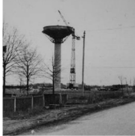
2.2 pav. Vandentiekio bokšto statybos Kėdainiuose, aut. nežinomas, 1971, LCVA
