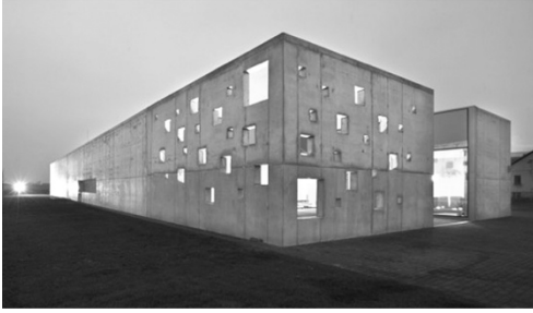
2.16 pav. Krematoriumas Kėdainiuose, archit. G. Natkevičius, 2011, G. Česonio nuotr. Fig. 2.16. Crematorium in Kėdainiai, arch. G. Natkevičius, 2011, photo by G. Česonis
