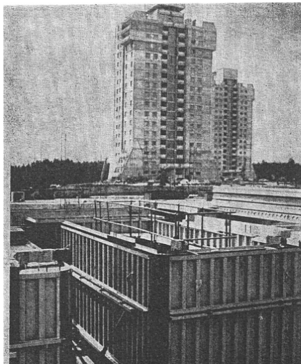
2.81 pav. Skydiniai perstatomi klojiniai Vilniuje, Lazdynuose, Statyba ir architektūra , 1984
