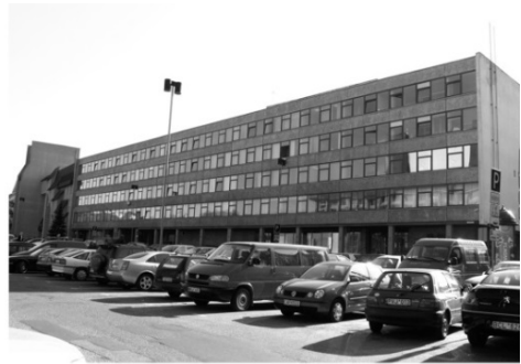
2.30. pav. Žemėtvarkos institutas Vilniuje, archit. N. Bučiūtė, 1967; iš asmeninio N. Bučiūtės archyvo,
