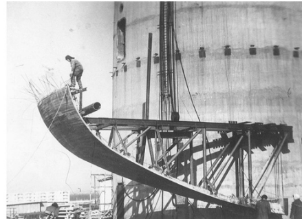
2.8 pav. TV bokšto gelžbetoninio kevalo montavimas, archit. V. Obydovas, K. Balėnas, 1979, Telecentro archyvas Fig. 2.8. Installation of a concrete shell for a TV tower, arch. V. Obydovas, K. Balėnas, 1979, Telecentre archive
