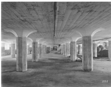
1.10 pav. Sandėlio interjeras Ciūriche, konstr. R. Maillart, 1910 (ETH biblioteka) Fig. 1.10. Lagerhaus Giesshübel in Zürich, 1910, constr. R. Maillart (ETH bibliothek)
