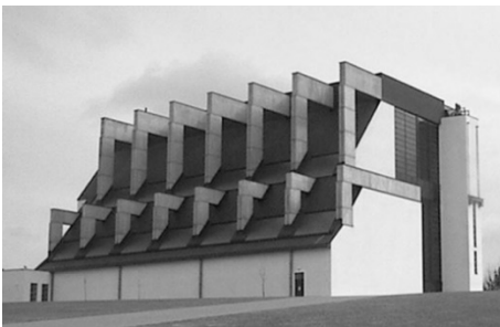
2.74 pav. Palaimintojo J. Matulaičio bažnyčia Vilniuje, archit. G. Baravykas, 1996, A. Černauskienės nuotr., 2018
