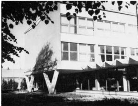
3.21 pav. Šilutės universalinė parduotuvė, archit. A. Patalauskas, A. Garunkščio nuotr., 1969, LCVA Fig. 3.21. Department store in Šilutė, arch. A. Patalauskas, photo by A. Garunkštis, 1969, LCVA
