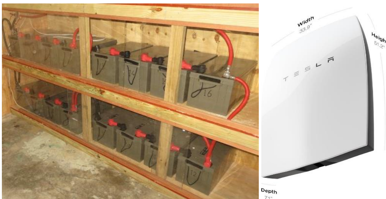
1.4 pav. Akumuliatorių laikymo pavyzdys (kairėje) naujos kartos akumuliatoriaus pavyzdys (dešinėje) 45
