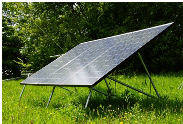
2 pav. Fotovoltinių modulių montavimo pavyzdys [5]
