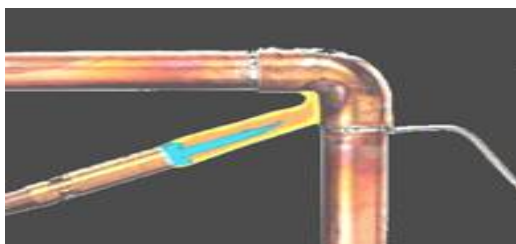
1.8 pav. Vamzdžių jungimas lituojant (14)
