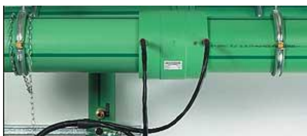
1.16 pav. Elektrinės movos jungimas suvirinimo aparatu (14)
