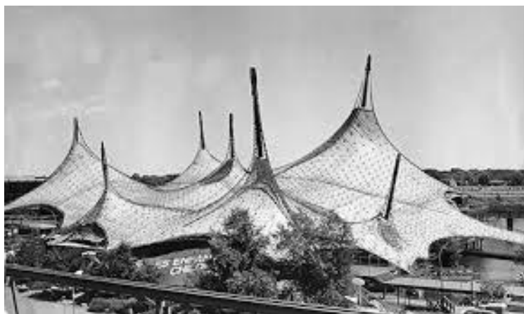
1.10 pav. Įtemptas kabamasis stogas Expo parodoje Montrealyje 1967 m. (Fabric makes home... 2015)
