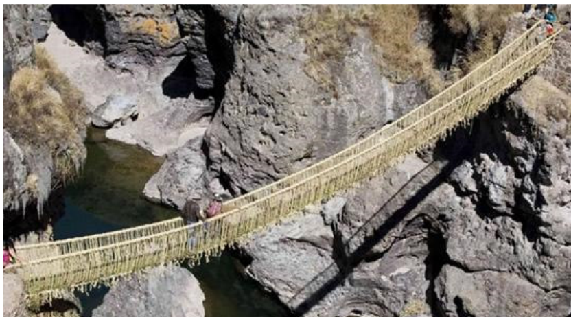
1.2 pav. Vienajuostis kabamasis Qeswachaka pėsčiųjų tiltas Kusko vietovėje, Peru (Qeswachaka – A Handwoven... 2010)
