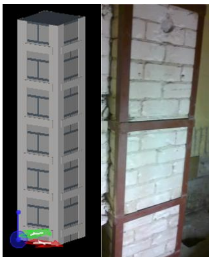
3.4 pav. Kolonos sustiprintos naudojant plieninių kampuočių apvalkalą
