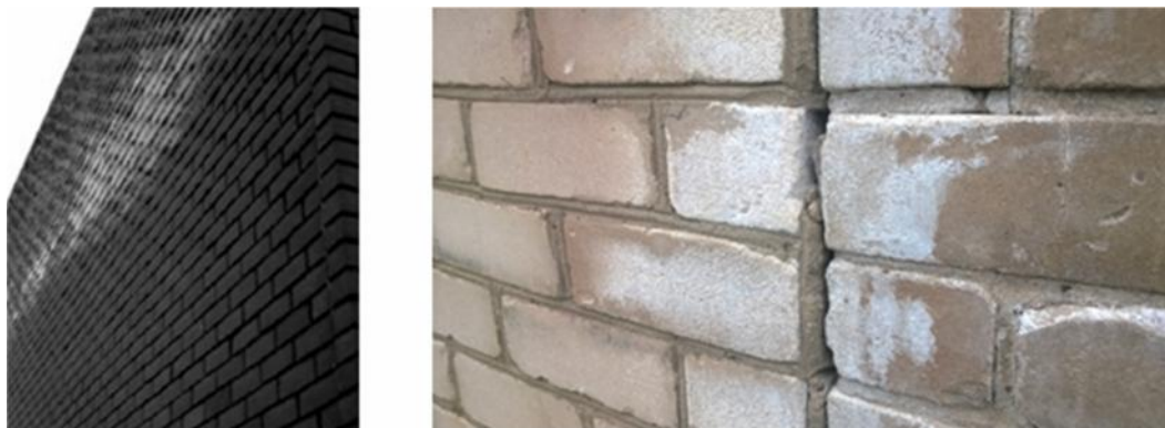
2.3 pav. Mūras, pasidengęs išplautų medžiagų sluoksniu
