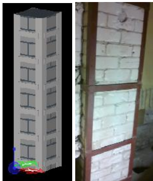
1. pav. Kolonos sustiprintos naudojant plieninių kampuočių apvaskalą
