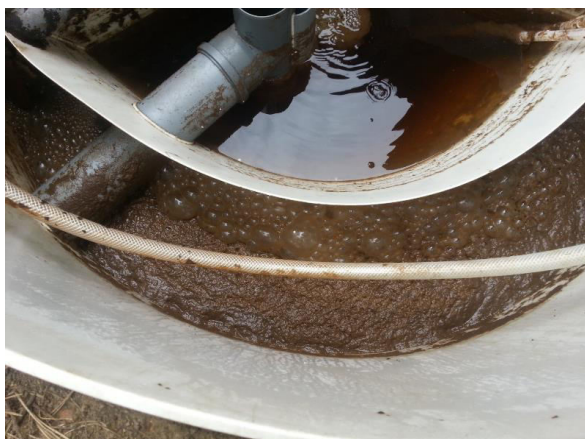
2.42 pav. Aeracinėje kameroje užputojęs veiklusis dumblas (Valeikaitė 2015).
