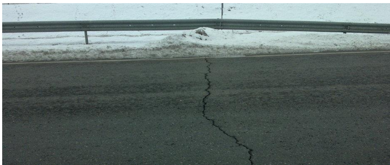
1.3 pav. Temperatūrinis plyšys (A. Vaitkaus nuotrauka)
