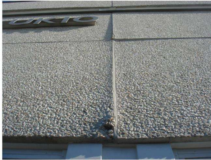
1.1 pav. Šalčio sukelta pastato fasado deformacija (Lahdensivu 2012)
