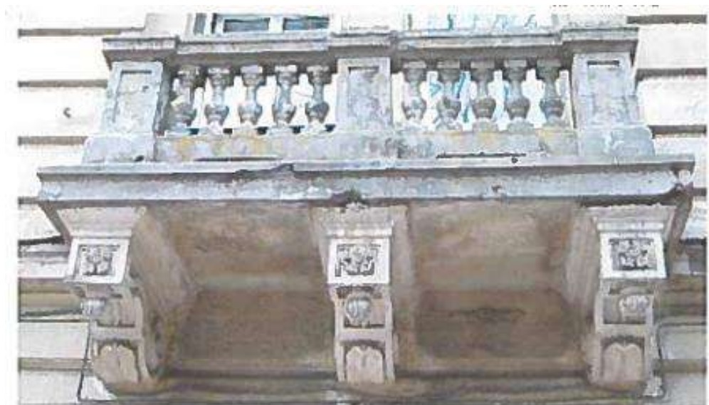
2.6 pav. Konsole paremtas balkonas, J. Basanavičiaus g. 23, Vilnius
