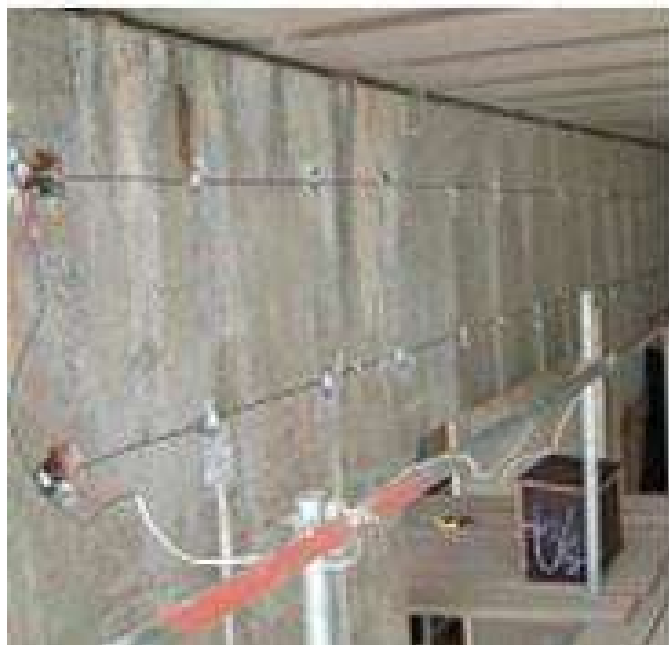
1.8 pav. Diskretiškieji anodai, įterpti į išgręžtas betono ertmes (Christodoulou et al. 2014)
