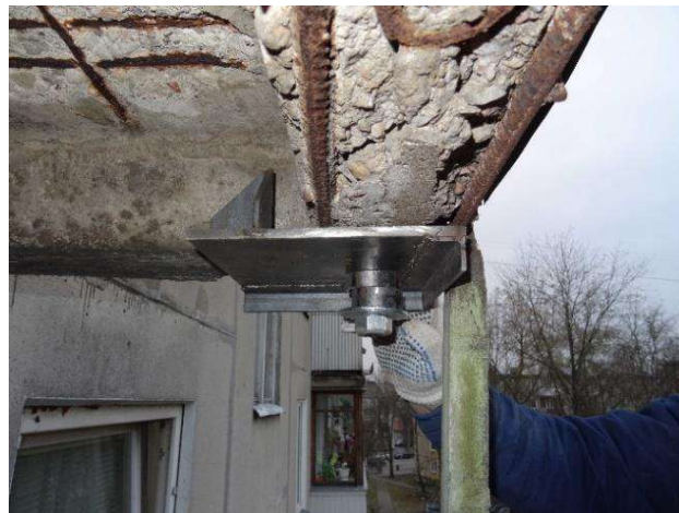
2.15 pav. Mazge A tvirtinamos detalės fotofiksacija (Elenbergas 2014)
