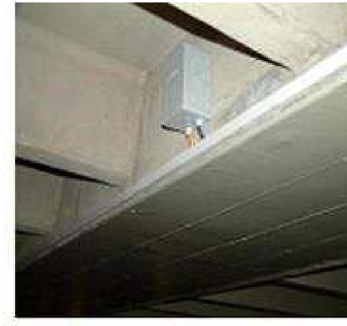
1.7 pav. Lipnūs cinko lakštai, pritvirtinti prie betono paviršiaus (Christodoulou et al. 2014)
