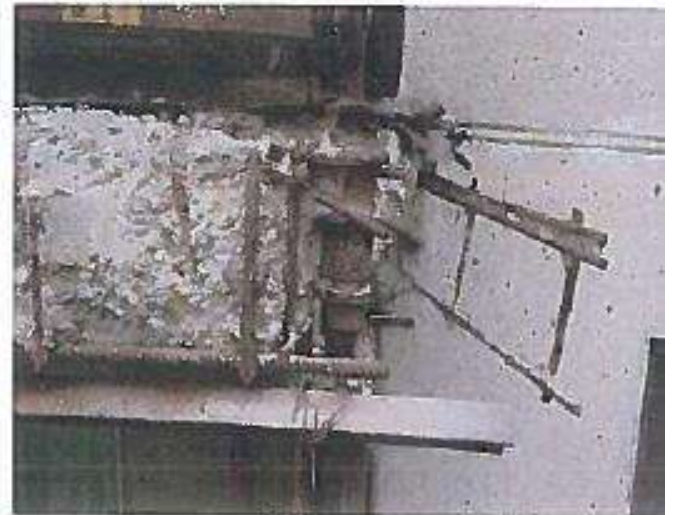
2.19 pav. Balkono Nr. 46 dešiniojo mazgo vaizdas prieš tyrimą. (geltona rodyklė žymi skersinę briauną, kuri yra atsilenkusi nuo plokštės ir sutrūkusi, raudona – išilginės ir skersinės armatūros nesusikirtimą.) (Elenbergas 2014)
