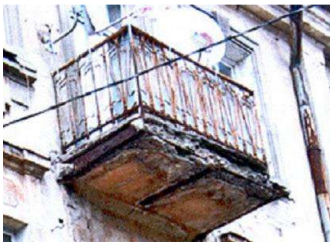
2.10 pav. Ant sienoje inkaruotų sijų įrengta betoninė plokštė, Šaltinių g. 8, Vilnius
