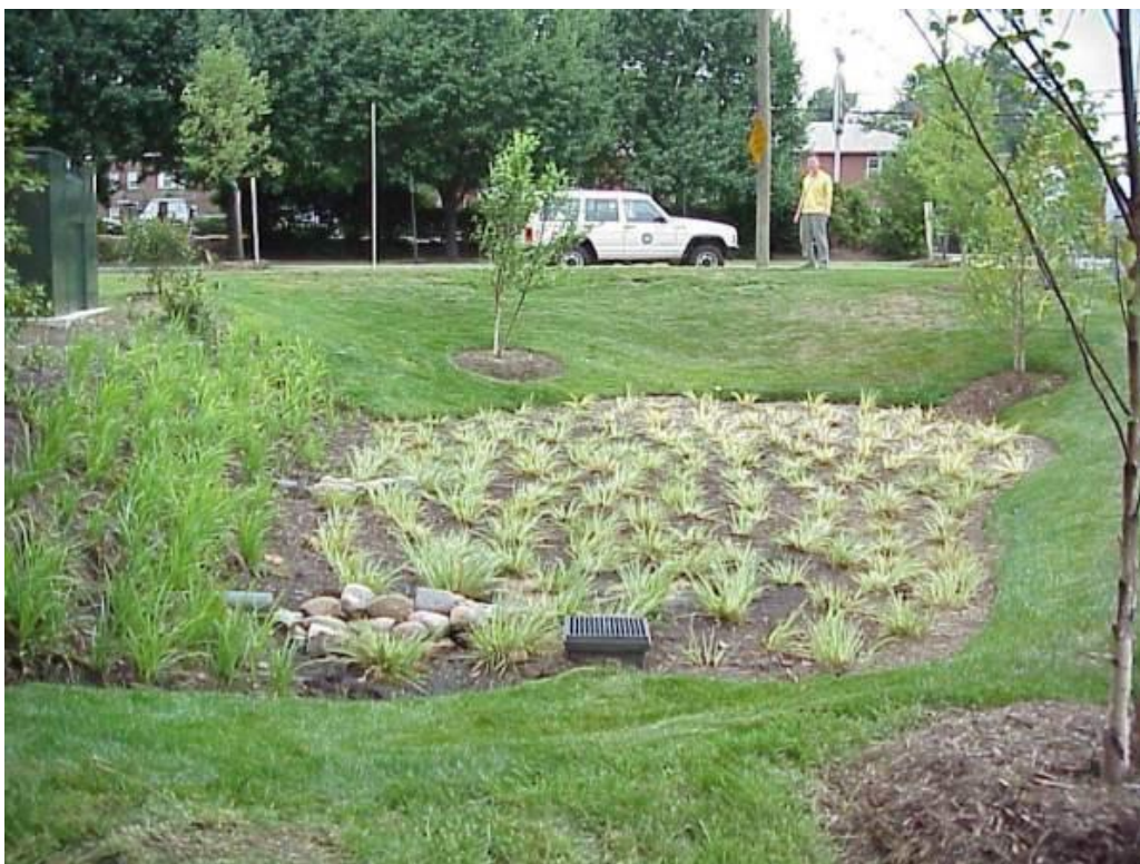
1.10 pav. Augalinio filtro, paviršinėms nuotekoms valyti, nuotrauka (Bioretention 2011)
