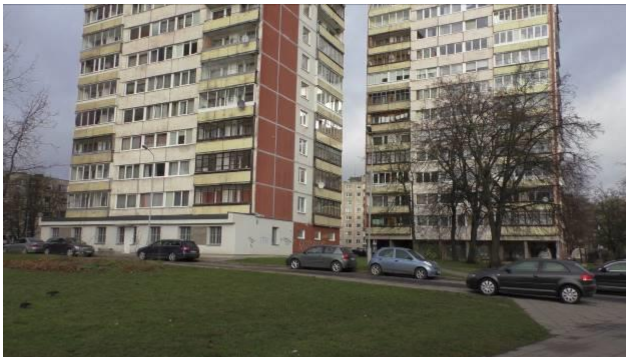
41 pav. L. Asanavičiūtės g.: Dvylikaaukščio cokolinis namo aukštas ne tik buvo pertvarkytas į patalpas, bet dar ir pailgintas. Tuo tarpu šalia esančiame daugiabutyje jokių rekonstrukcijos darbų nebuvo vykdoma ir jau daugelį metų šio pastato erdvės kelia nemaloniais asociacijas.
