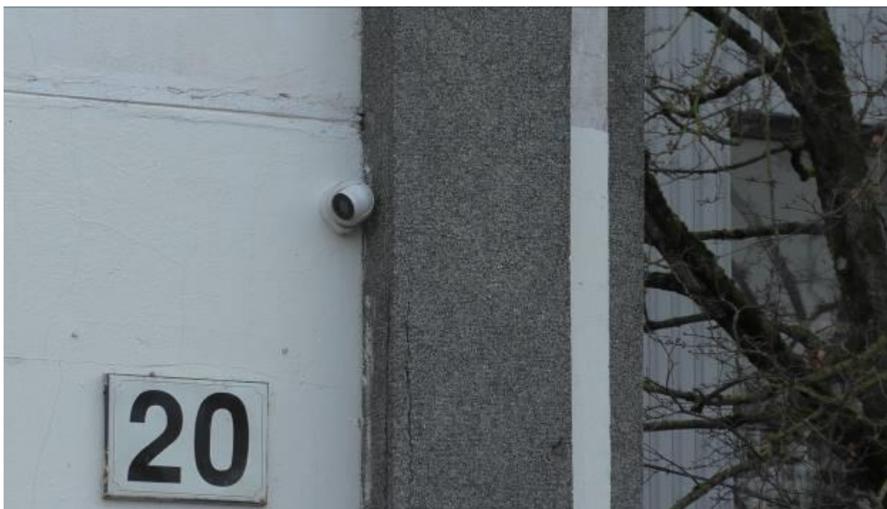
56 pav. A.J. Povilaičio g. prie Laisvės pr.: 55 pav. pavaizduotos vietos fragmentas. Vaizdo stebėjimo kamera įrengta taip, kad apimtų visą teritoriją ir objektą (sienas, įėjimą, langus).
