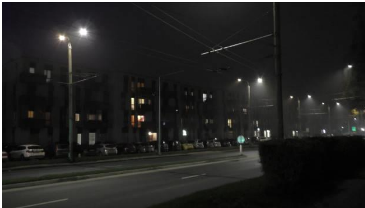
33 pav. L. Asanavičiūtės g.: Prie naujo statybos namo buvo įrengti dvigubi žibintai, nukreipti ir į kelio pusę, ir į šalia esanti pėsčiųjų taką bei namo automobilių stovėjimo aištelę. Matomumas tamčiuoju metu pastebimai pagerėjo.
