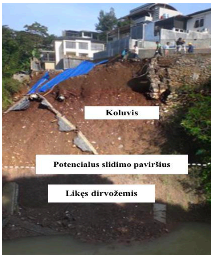
18 pav. Atraminės sienos griūtis (pagal Lim, 2018)
