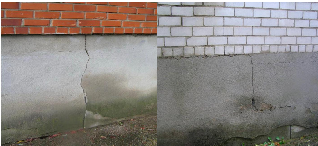
4 pav. Pamatų sienos deformacija (Endriejavo vidurinė mokykla)
