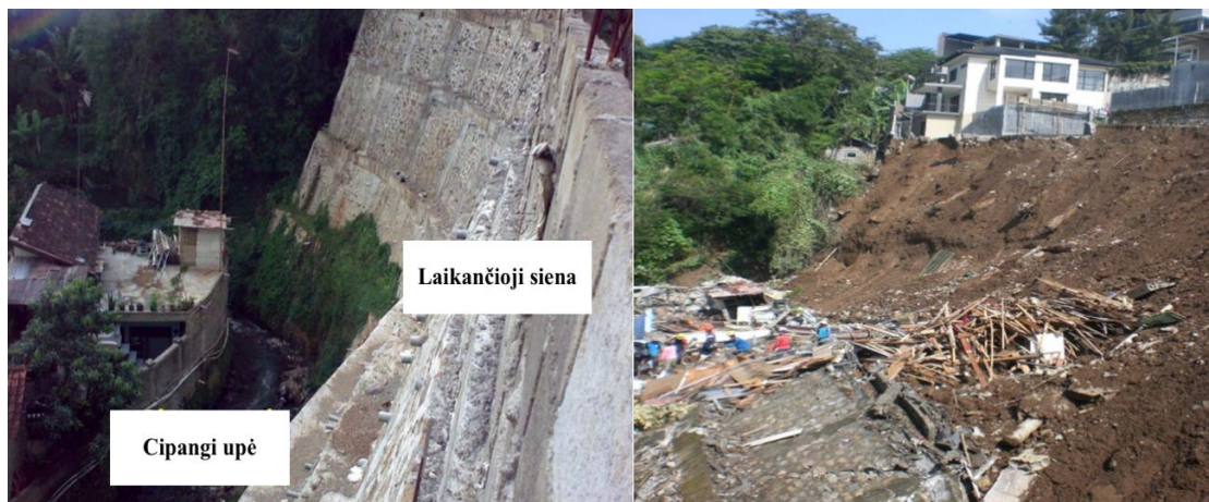
17 pav. Atraminės sienos griūtis (pagal Lim, 2018)
