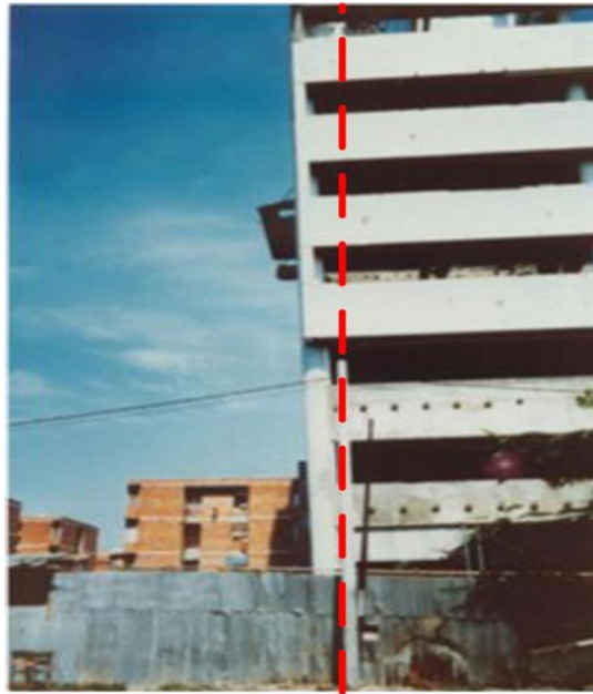
16 pav. Pastato deformacija po kasimo darbų (pagal Poulos, 1991)
