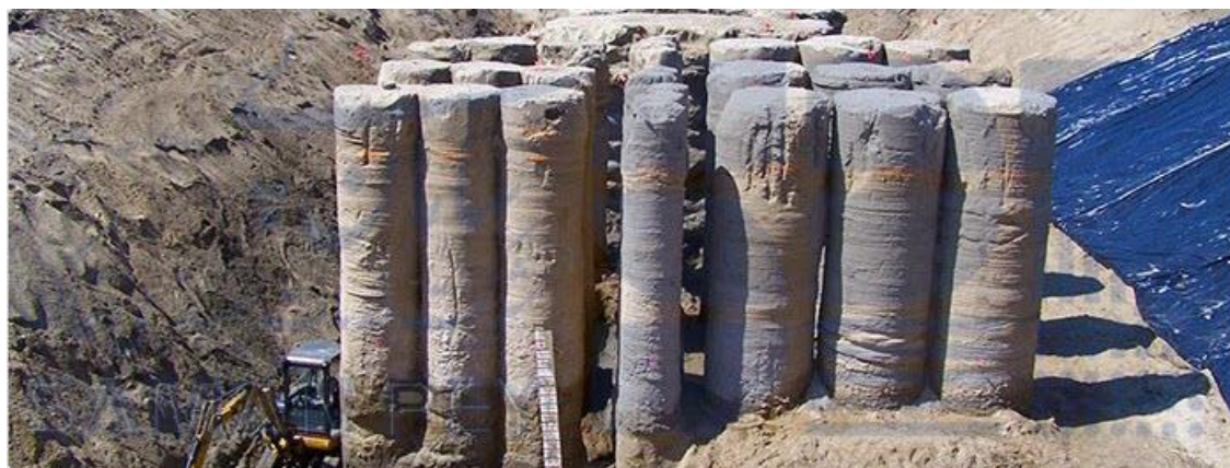
2 pav. Gruntbetonio kolonos (Samanpey, 2020)
