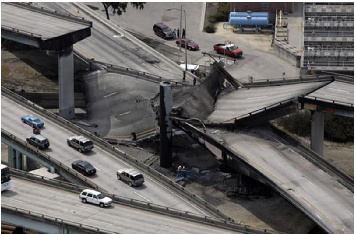
2.21 pav. Transporto mazgas tie JAV Oklendo miestą ir benzovežio gaisro tarp transporto estakadų padariniai (Quiel et al. , 2015)
