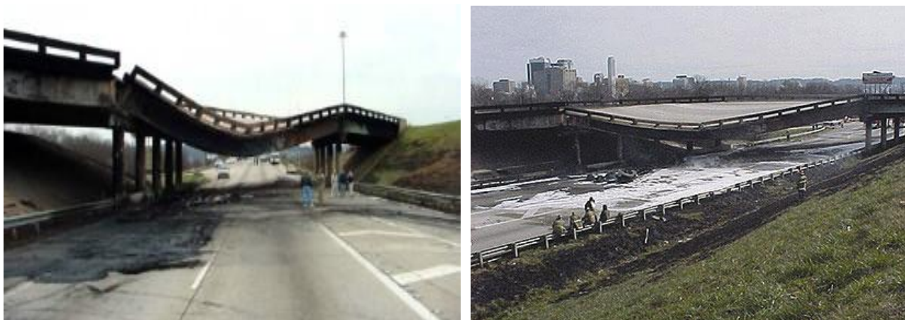
2.22 pav. Benzovežio gaisro po viaduku su plieninėmis perdangos sijomis padariniai (Alos-Moya et al. , 2014)
