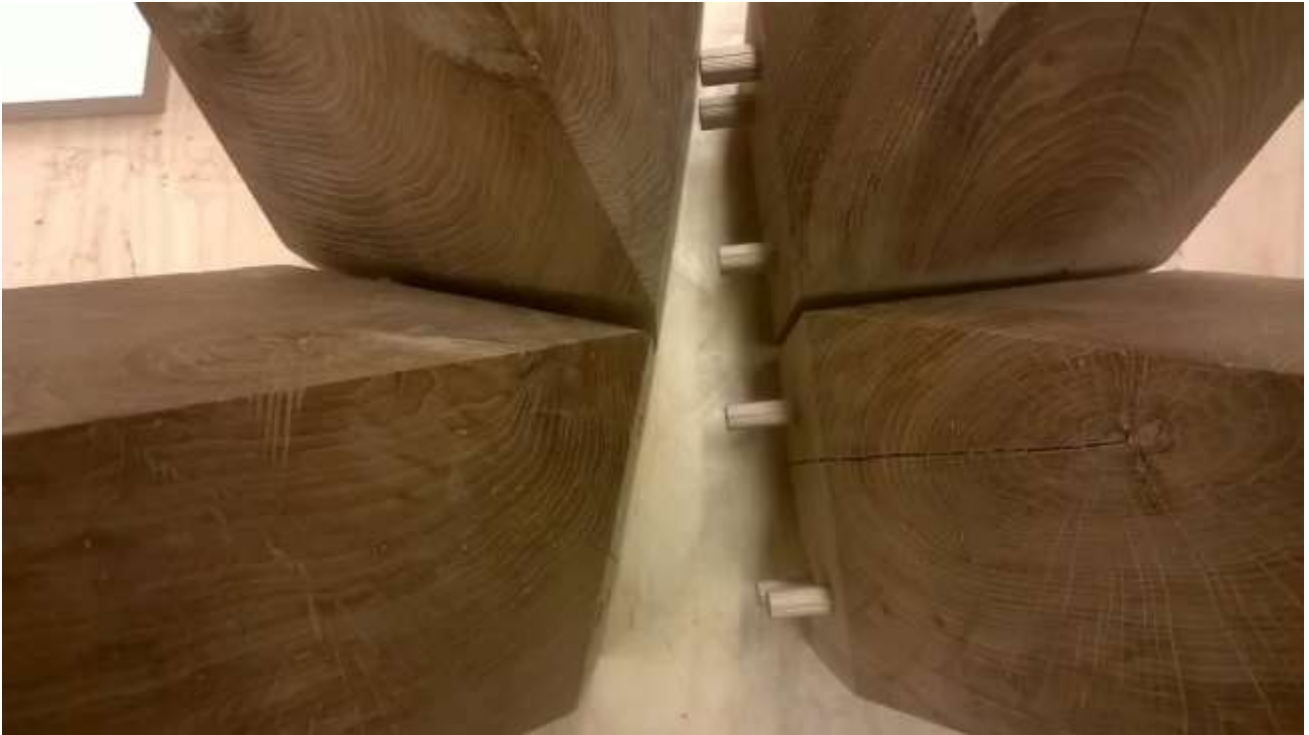
60 pav. Pasiruošimas konstrukcijos klijavimui. Naudojami ovalaus skerspjūvio „Festo“ kaiščiai. Objektas Nr. 1.
