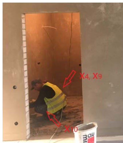
25 pav. Nepatogi tinkuotojo darbo poza dėl kojų ir nugaros įtampos
