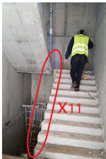
17 pav. Betonuotojo rizika nukristi iš aukščio
