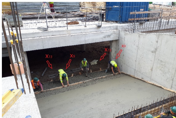
15 pav. Nepatogi betonuotojo darbo poza dėl nugaros įtampos
