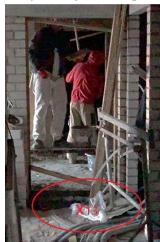
27 pav. Tinkuotojo pavojus užkliūti už kliūčių ir nukristi
