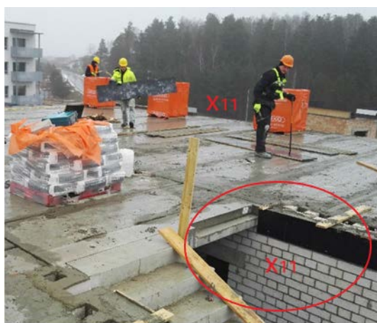
22 pav. Pavojus mūrininkui nukristi iš aukščio
