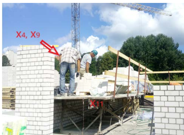
21 pav. Pavojus mūrininkui nukristi, daugartiniai liemens palenkimai
