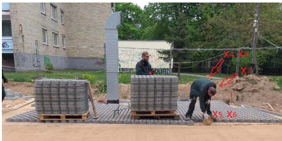
30 pav. Daugkartiniai liemens palenkimai, rankų ir pečių juostos įtampa
