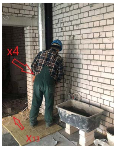
26 pav. Priverstiniai tinkuotojo liemens palenkimai, galimybė užkliūti už kliūčių ir nukristi
