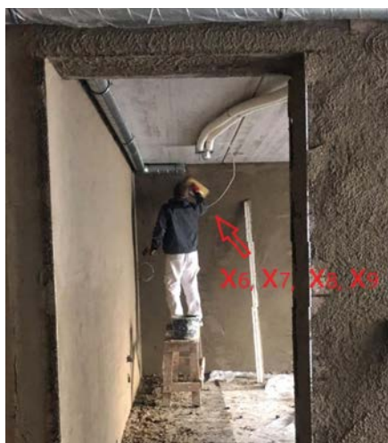
24 pav. Nepatogi tinkuotojo darbo poza dėl rankų įtampos
