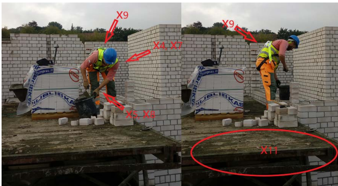
20 pav. Nepatogi mūrininko darbo poza dėl nugaros įtampos ir daugkartinių liemens palenkimų
