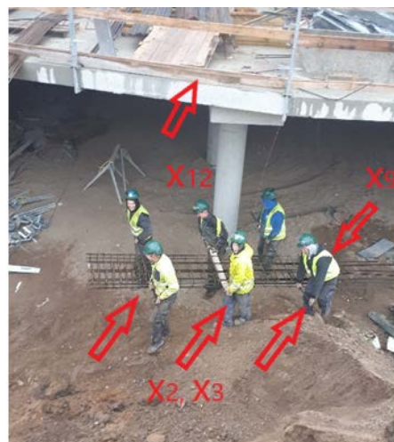
18 pav. Betonuotojų keliamas ir nešamas krovinys
