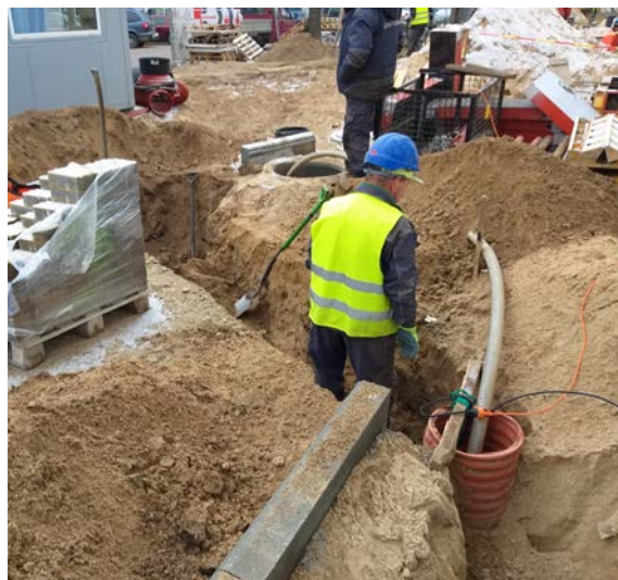
29 pav. Pavojus dėl daiktų kritimo iš aukščio, žemės užvirtimo
