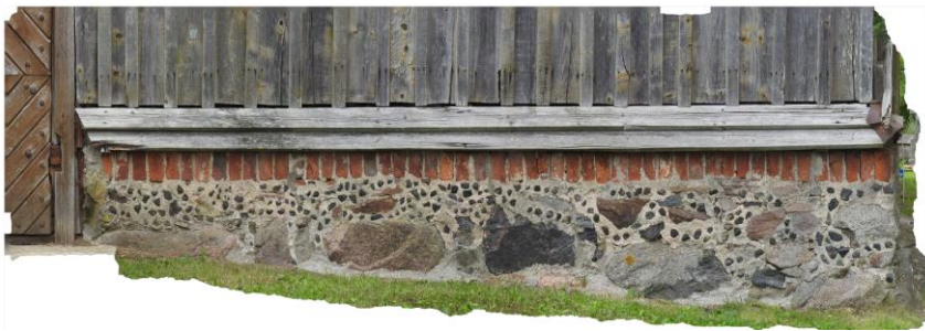
6 pav. ~27 Megapikselių ortofotografija – tai tikslios geometrijos, aukštos rezoliucijos foto-fiksacija, tinkanti matavimams atlikti. Paimta iš VŠĮ „Paveldo komunikacija“, UAB „Terra Modus“ archyvų.
