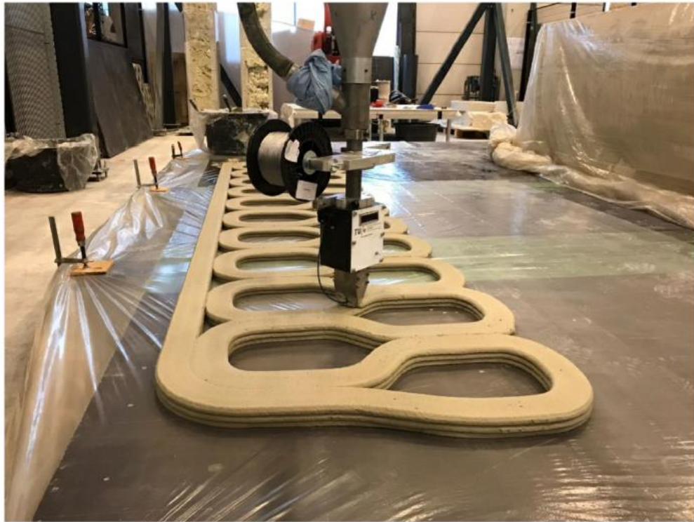
1.12 pav. Betoninio segmento spausdinimas, tiesiogiai liejant betoną ir vielą vienu metu (Bos et al., 2017)
