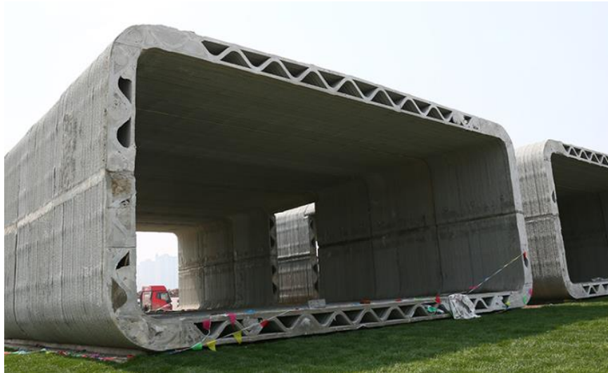
2.1 pav. Kompanijos WinSun produktas, moduliniai blokai („WinSun“, 2019)
