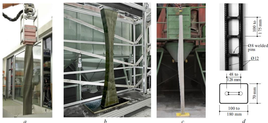
1.9 pav. SDC metodu pagaminti elementai (Lloret-Fritschi, 2016): a) žvaigždės formos standus klojinys, 180° kampas besisukant per visą kolonos aukštį, b) 2m aukščio sienos elementas, pagamintas naudojant lanksčius klojinius, c-d) vertikalus sienos elementas, skirtas langams atitverti, ir jo geometrija
