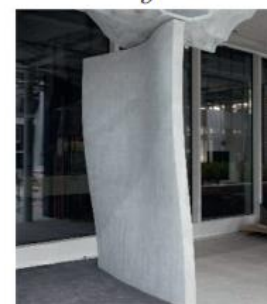
1.10 pav. MM technologija: a) 14m ilgio, dvigubo kreivumo sienos karkasas, b) karkaso užpildymas, c) 3m aukščio sienos maketas (DFAB HOUSE, 2018)
