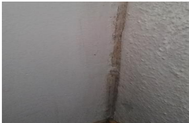
29 pav. Mikroskopiniais grybais pažeista siena antrame bute
