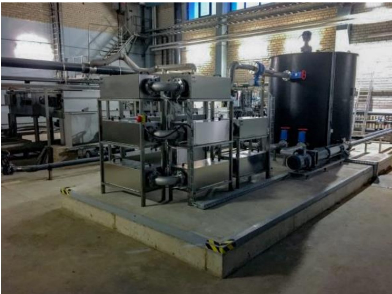
14 pav. Dumblo skaidymo technologija Kauno nuotekų valykloje (nuotrauka iš asmeninio archyvo)
