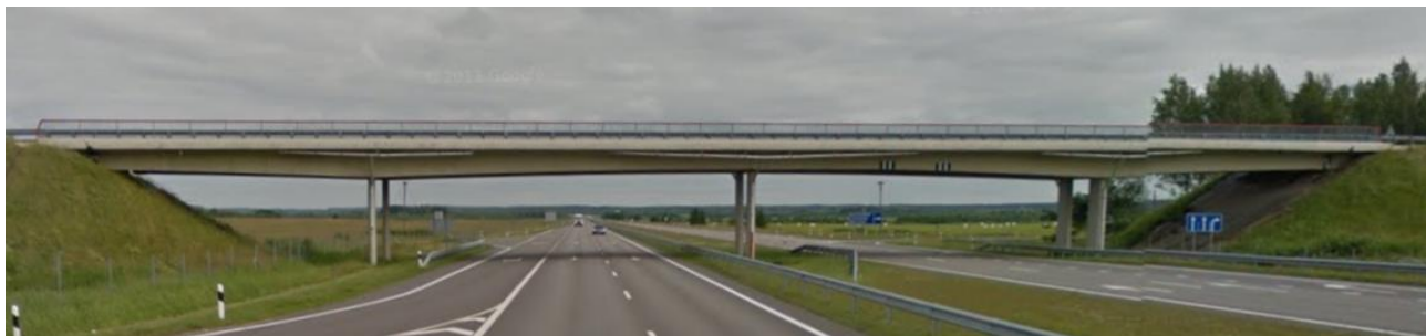
48 pav. Viadukas, sustiprintas įrengus tarpinės atramas (A2 ir E272 kelių sankirta) [14]
