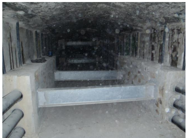
19 pav. Įtemptosios armatūros išdėstymas (Nemenčinės viadukas)
