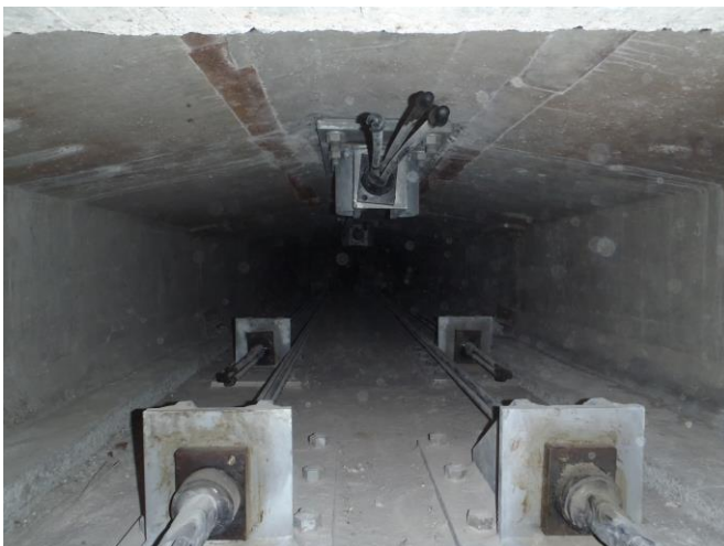
17 pav. Įtemptosios armatūros išdėstymas
