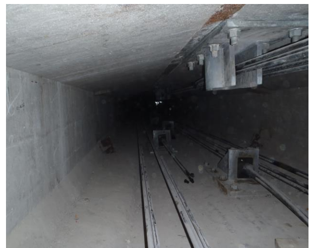
17 pav. Įtemptosios armatūros išdėstymas
