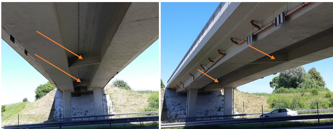
24 pav. Skersinės sijos, jungiančios dėžines sijas tarpusavyje
