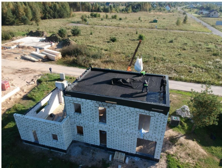
3.9 pav. Hidroizoliacijos patikra, naudojant bepilotį orlaivį (autorius nuotrauka)
