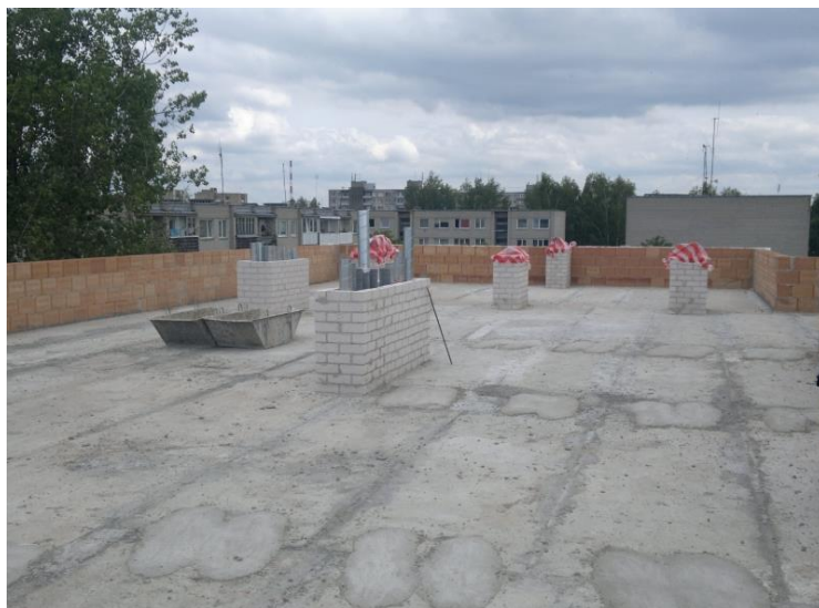
1.1 pav. Gelžbetoninė perdanga (autorius nuotrauka)
