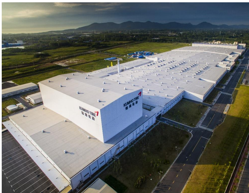
2.8 pav. Plokščias stogas, padengtas „Firestone UltraPly“ TPO danga (Naujausi projektai 2017)
