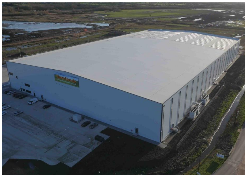
2.7 pav. Plokščias stogas, įrengtas iš IKO gaminamos PVC dangos (IKO istorija 2017)
