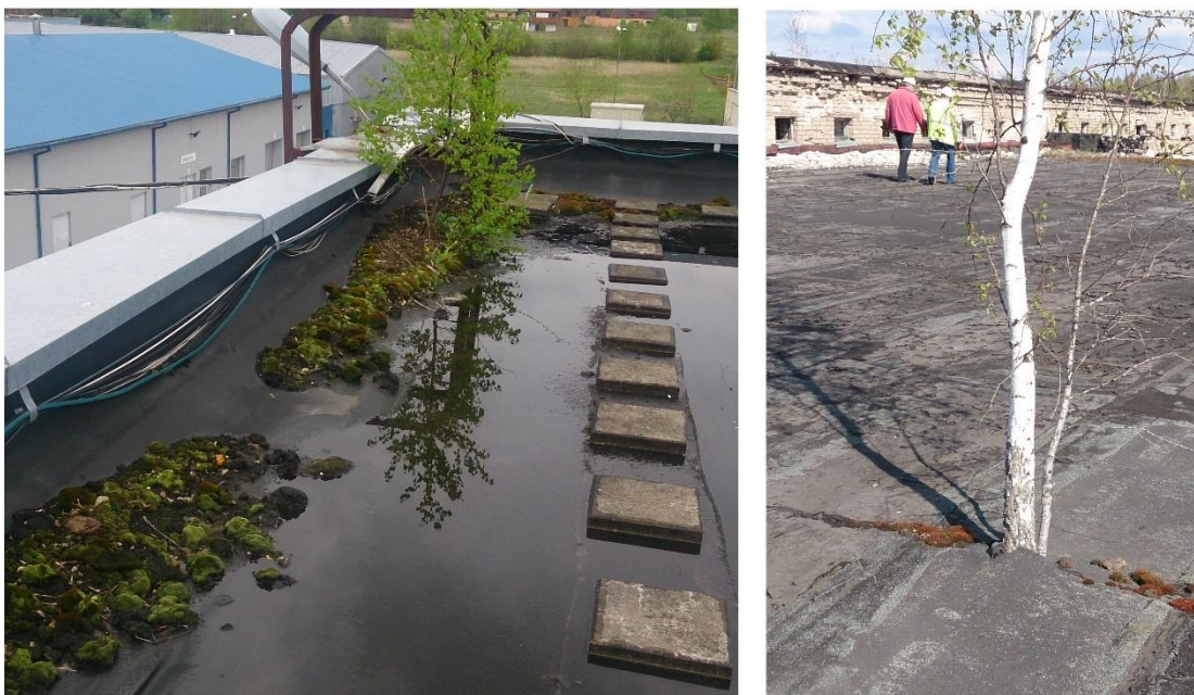
1.11 pav. Ant plokščio stogo augančios samanų ir medžiai dėl netinkamo nuolydžio (autorius nuotrauka)
