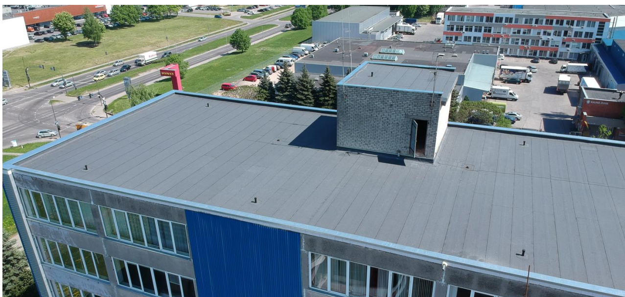
2.2 pav. Stogas įrengtas iš prilydomų stogo dangų (autorius nuotrauka)
