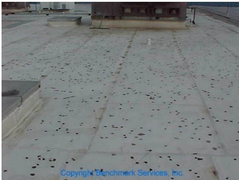
2.10 pav. PVC dangoje matomos skylutės, atsiradusios po krušos (Vitiello 2007)
