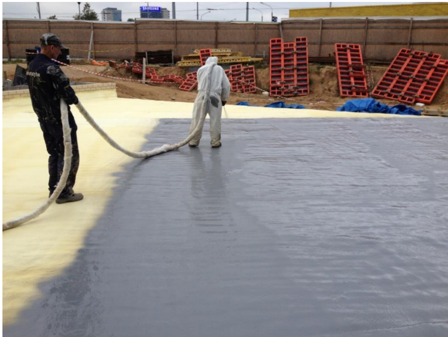
2.1 pav. Skysta hidroizoliacinė danga – poliurėja (Aukštuminių pastatų... 2017)
