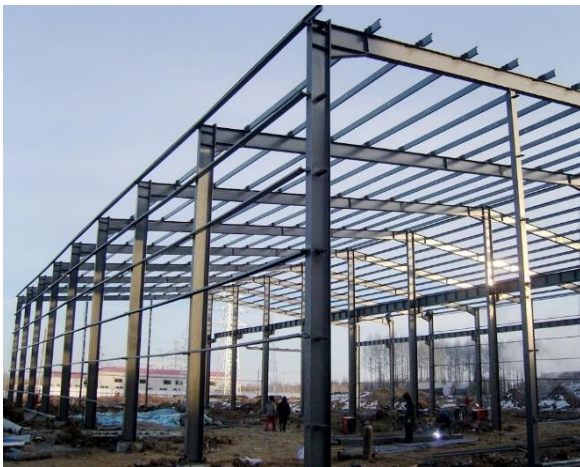
1.1 pav. Pastovaus skerspjūvio portalinio rėmo pavyzdžiai (Single storey...2017)
