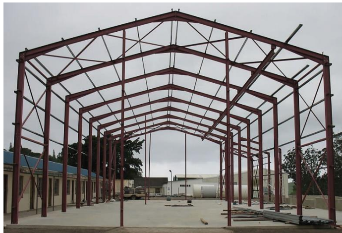
1.1 pav. Pastovaus skerspjūvio portalinio rėmo pavyzdžiai (Single storey...2017)
