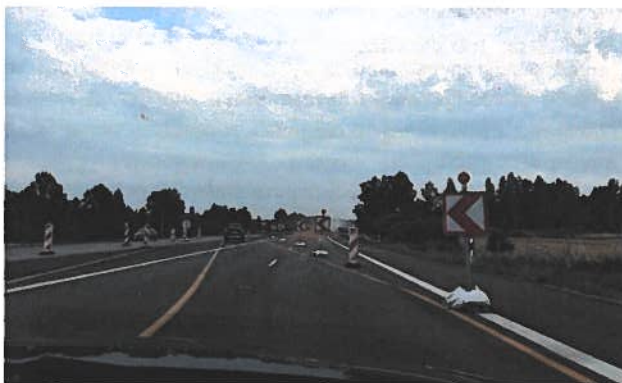
Рисунок 6 – Нанесение долгосрочной и краткосрочной горизонтальной разметки в рабочих зонах
