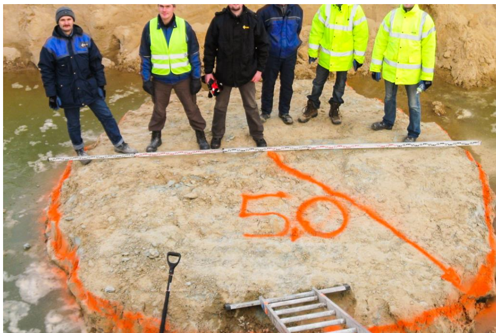
1.3 pav. Pasiektas didelio slėgio injekcijos Lenkijos rekordas – 5,0 m skersmens gruntbetonio kolona (Keller Polska 2015)
