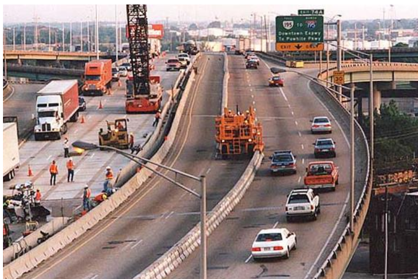
2.10 pav. Eismo juostų keitimo metodas panaudojant betono barjerų perkėlimo mašiną „Road zipper“ (www.roadtothefuture.com)
