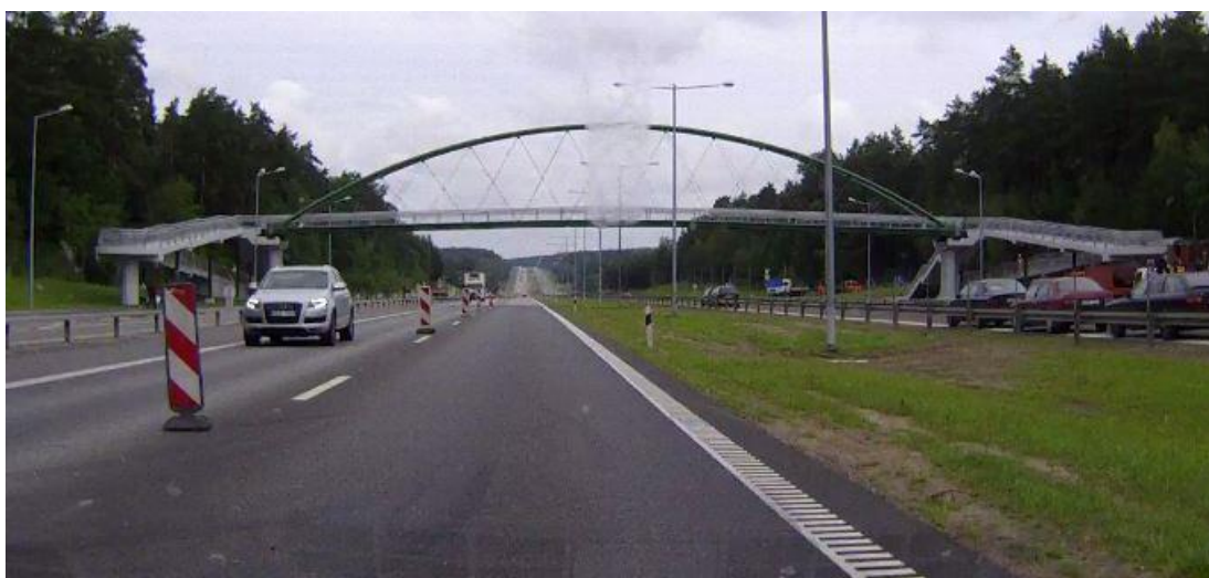
3.6 pav. Magistralinio kelio A2 Vilnius-Panevėžys (71,6–72,8 km) darbų zonoje naudojamos aptvėrimo ir eismo organizavimo priemonės (fotografuota autoriaus, 2016)
