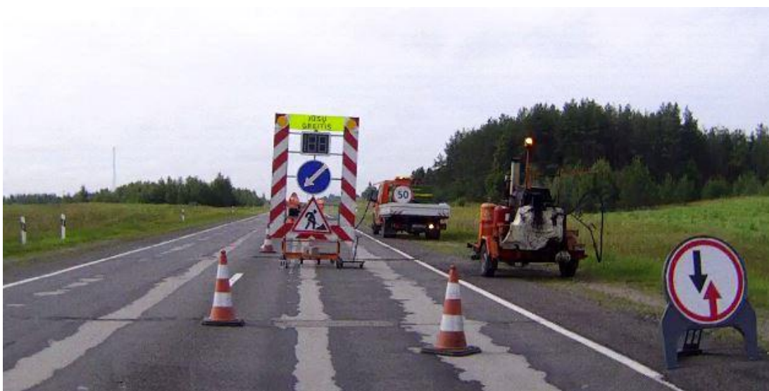
3.11 pav. Kilnojamas atitvėrimo skydas su momentinio greičio matuokliu Kelio A14 Vilnius-Utena (79,5–79,7 km) trumpalaikių kelio darbų vykdymo zonoje (fotografuota autoriaus, 2016)
