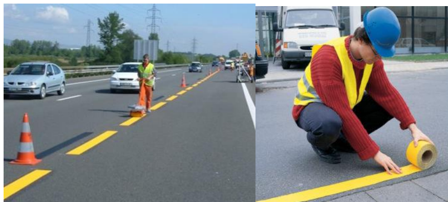
2.6 pav. Laikinas horizontalusis ženklavimas: a) nuplaunami dažai (www.lindsay.com); b) klijuojama laikina horizontaliojo ženklavimo juosta (www.jugima.lt.)
