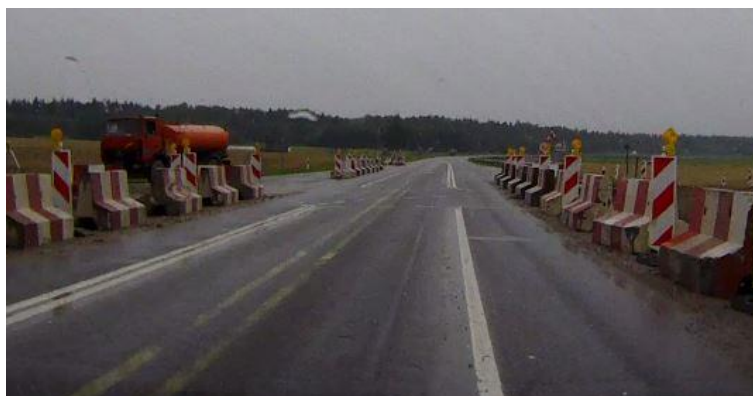
3.9 pav. Kelio A5 Kaunas-Marijampolė-Suvalkai (39,0–45,0 km) darbų zonoje naudojamos aptvėrimo ir eismo organizavimo priemonės (fotografuota autoriaus, 2016)
