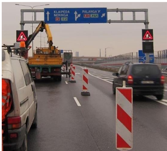
2.8 pav. Kintamosios informacijos kelio ženklas kelių darbų zonoje ( www.ebus.lt )
