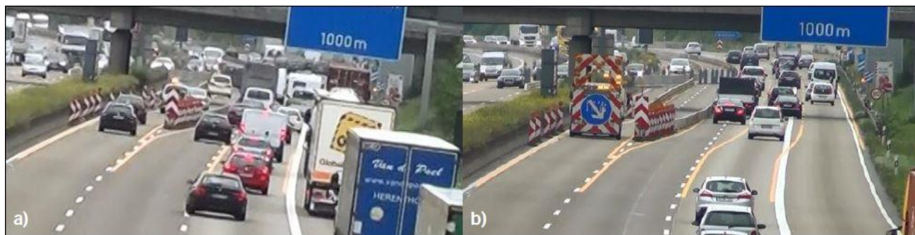
2.9 pav. Eismo organizavimo metodas panaudojant reversines eismo juostas: a) reversinė juosta atidaryta eismui; b) reversinė juosta uždaryta eismui (Waleczek et al. 2016)
