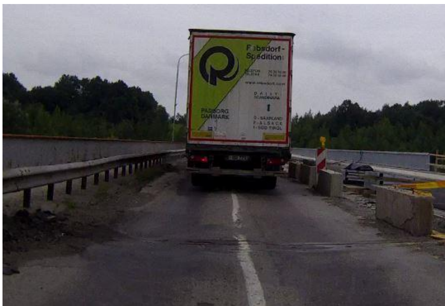
3.10 pav. Kelio A6 Kaunas-Zarasai-Daugpilis (33,7–34,9 km) darbų zonoje naudojamos aptvėrimo ir eismo organizavimo priemonės (fotografuota autoriaus, 2016)
