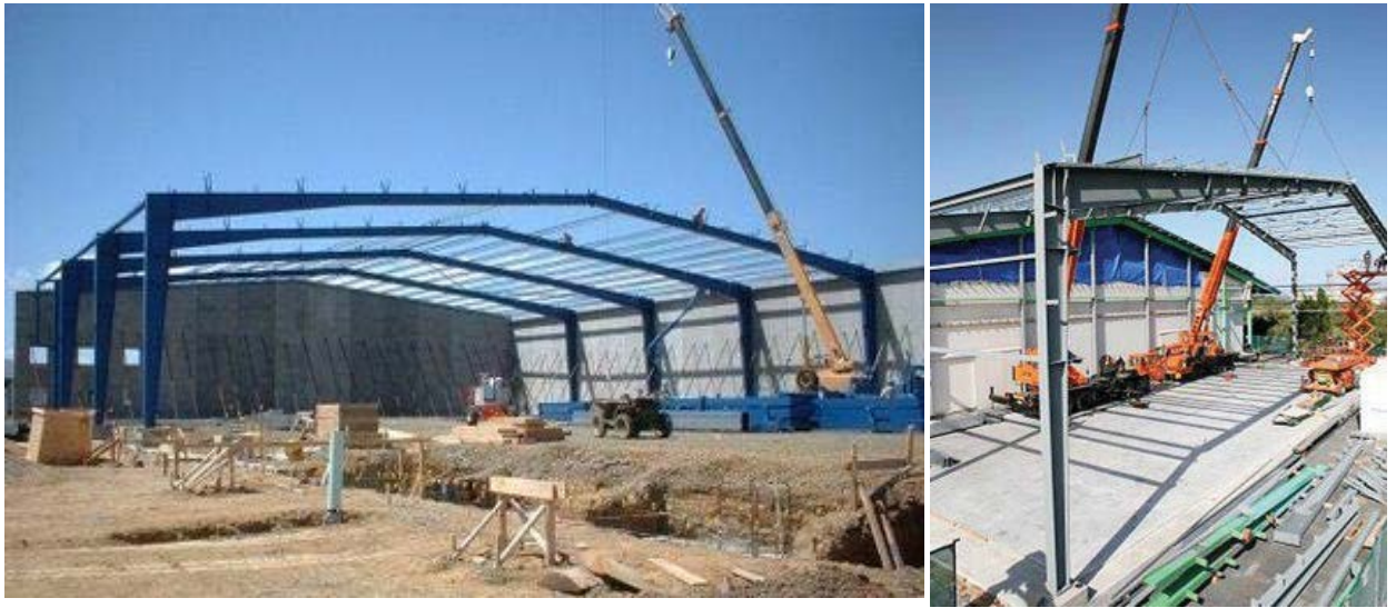
1.1 pav. Portalinių rėmų pavyzdžiai (Design... 2013)
