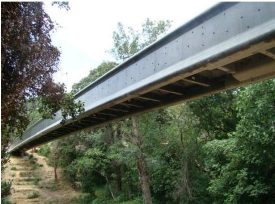
Figure 17 Pont Du Diable Footbridge
