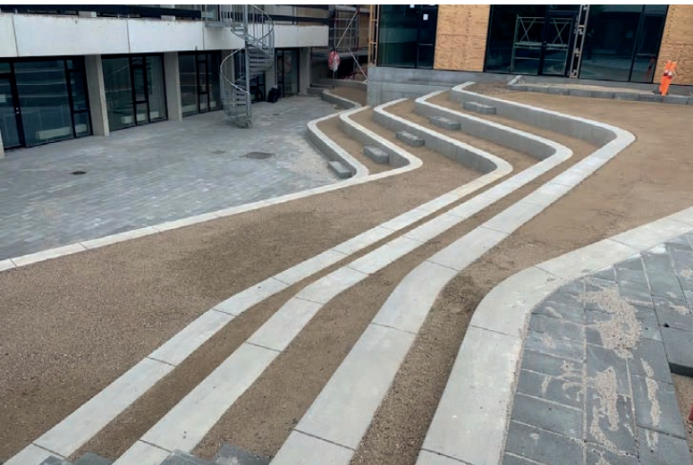
↑ Betoninės sienelės amfiteatrui.
