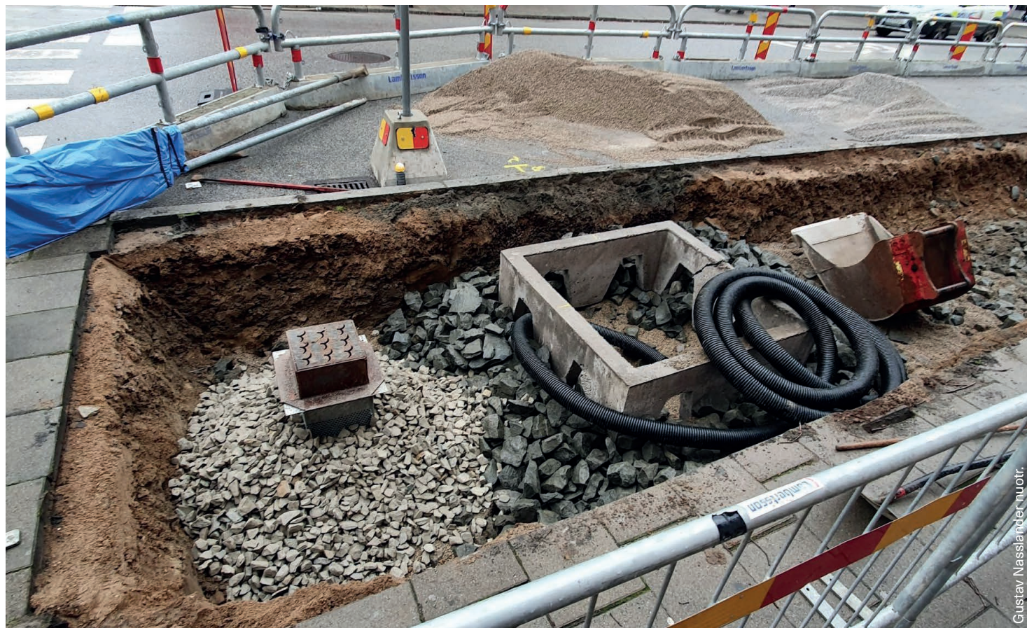
↑ Gerasis pavyzdys – naujam sodinimui paruošiamas struktūrinis gruntas.
