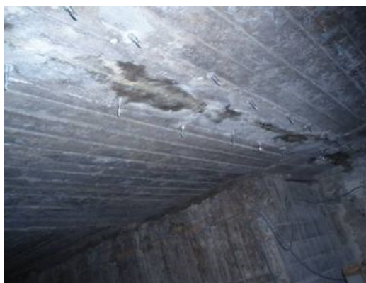
1.20 pav. Monolitinių ruožų injektavimas (Gelžbetonio injektavimas 2014)
