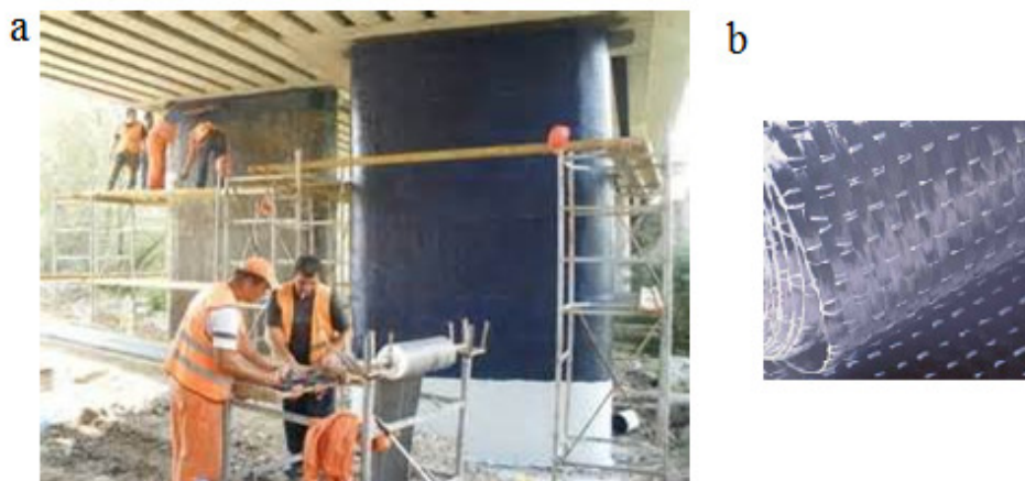
1.12 pav. Didelio stiprumo vienkryptis anglies pluošto audinys, pasižymintis labai aukštu tamprumo moduliu: a) anglies pluošto audinio įrengimas; b) vienkryptčio anglies pluošto audinio struktūra (Konstrukcijų stiprinimas...2013; Unidirectional carbon...2013)
