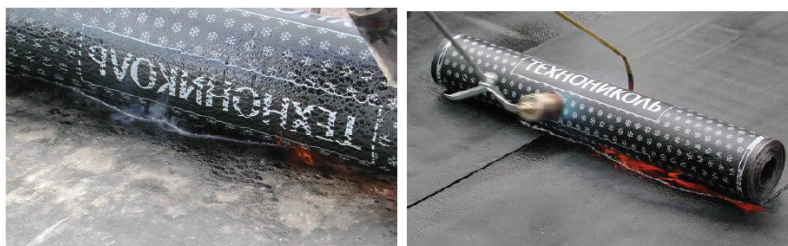
12 pav. Pašildytos polimerinės-bituminės masės banga („Mida“ dangų gamintojų rekomendacijos)
