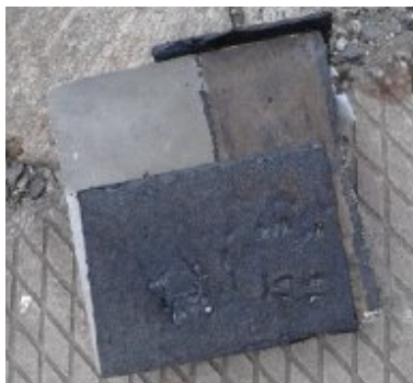
27 pav. Betoninė bandymo plokštė
