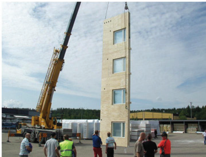
13 pav. Iš gamyklos skydai atvežami į statybviетę („Inova“ projektas... 2013)
