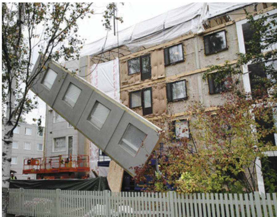
14 pav. Skydų tvirtinimas prie fasado („Inova“ projektas... 2013)
