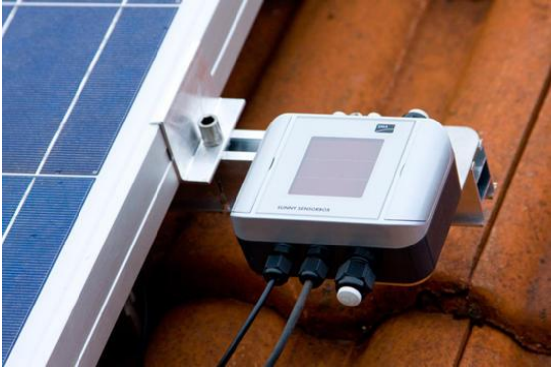
3.3 pav. Tiesioginės saulės energinės apšvietos matavimo prietaisas „Sunny SensorBox“
