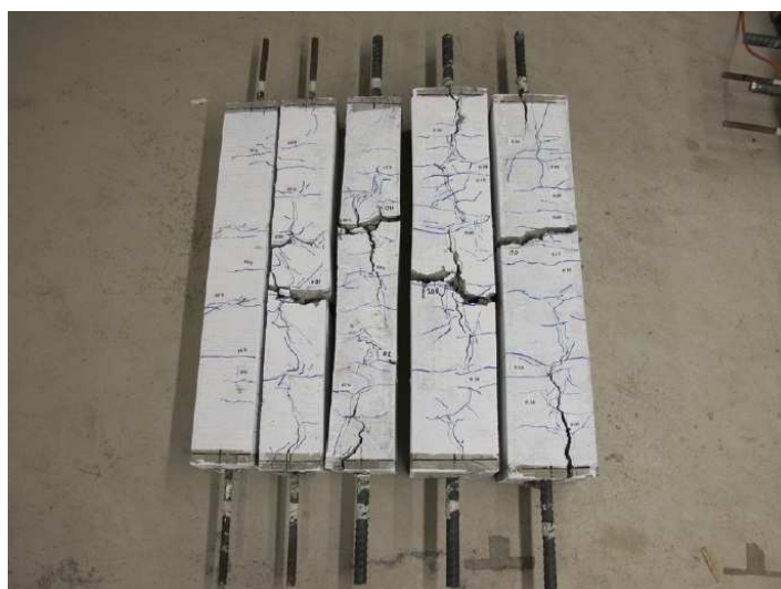
A.6 pav. FRC5 ( V_f = 1,5 \% , l/d_f = 48 ) betono mišinio išilginiu armatūros styriu armuotos supleišėjusios prizmės (Deluce 2011)
