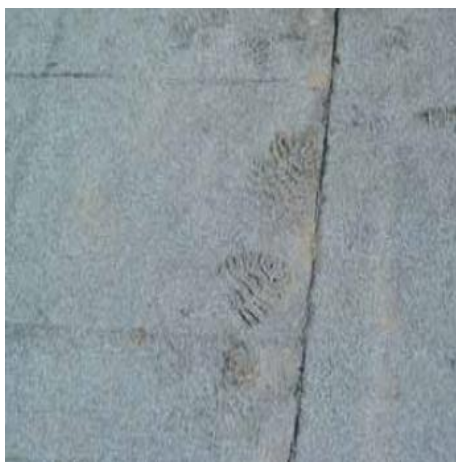
1.17 pav. Perkaitinta stogo danga (Walter et al. 2004 )
