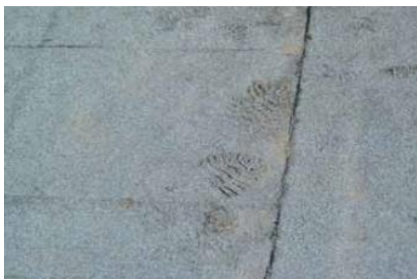
2.23 pav. Perkaitinta stogo danga (Walter et al. 2004)
