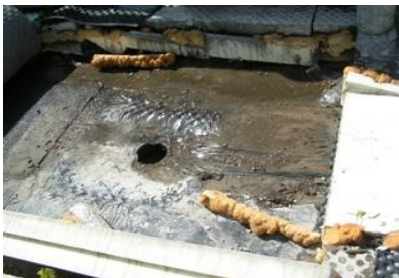
2.25 pav. Hidroizoliacinės dangos praspaudimas (Karablikovas 2011)
