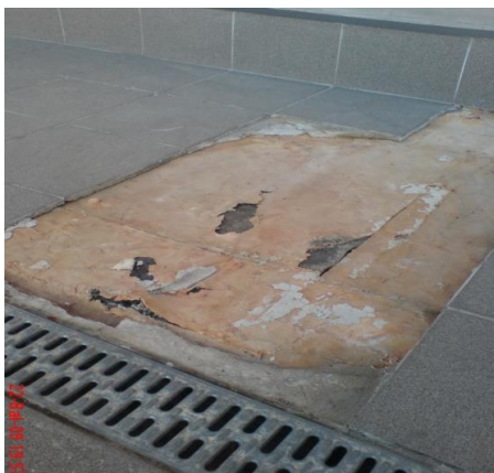
2.30 pav. Atplėštos nuo pagrindo plytelės (Karablikovas 2011)
