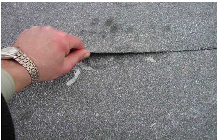
2.24 pav. Per mažai šildyta siūlė (Walter et al. 2004)
