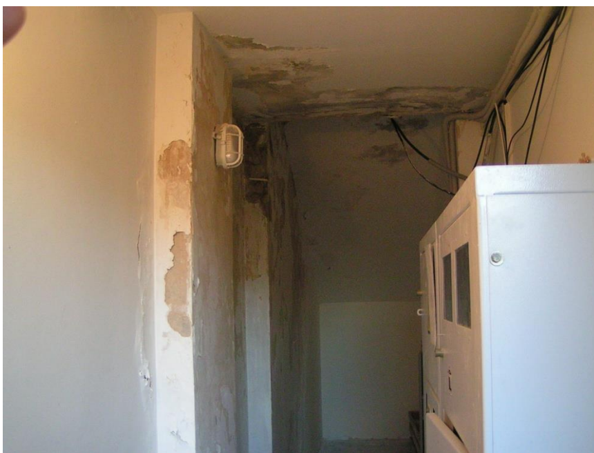
2.32 pav. Pažeista sienos ir lubų konstrukcija (Karablikovas 2011)
