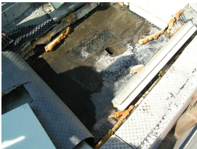
2.28 pav. Sutrinti lakštai, praspasta hidroizoliacinė danga (Karablikovas 2011)
