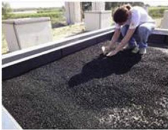
1.22 pav. Perdirbtos gumos drenažas žaliajam stogui (Rincon et al. 2014)
