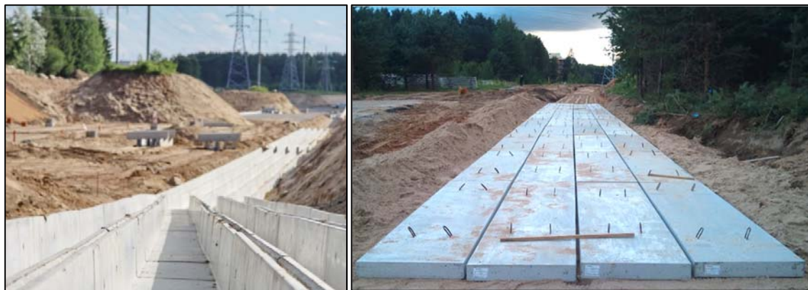
2.12 pav. Kabelinės elektros linijos įrengimo darbai (Vakarinio... 2014)
