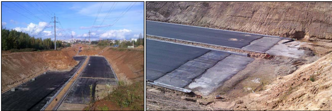
2.11 pav. Pradiniai kelio dangos įrengimo darbai (fotografuota autoriaus)
