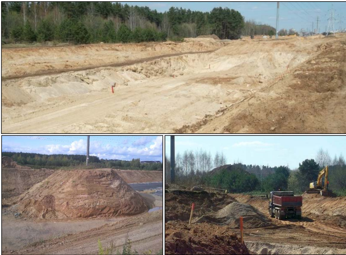
2.10 pav. Vakarinės greito eismo gatvės iškasos formavimo darbai (Vakarinio... 2014)
