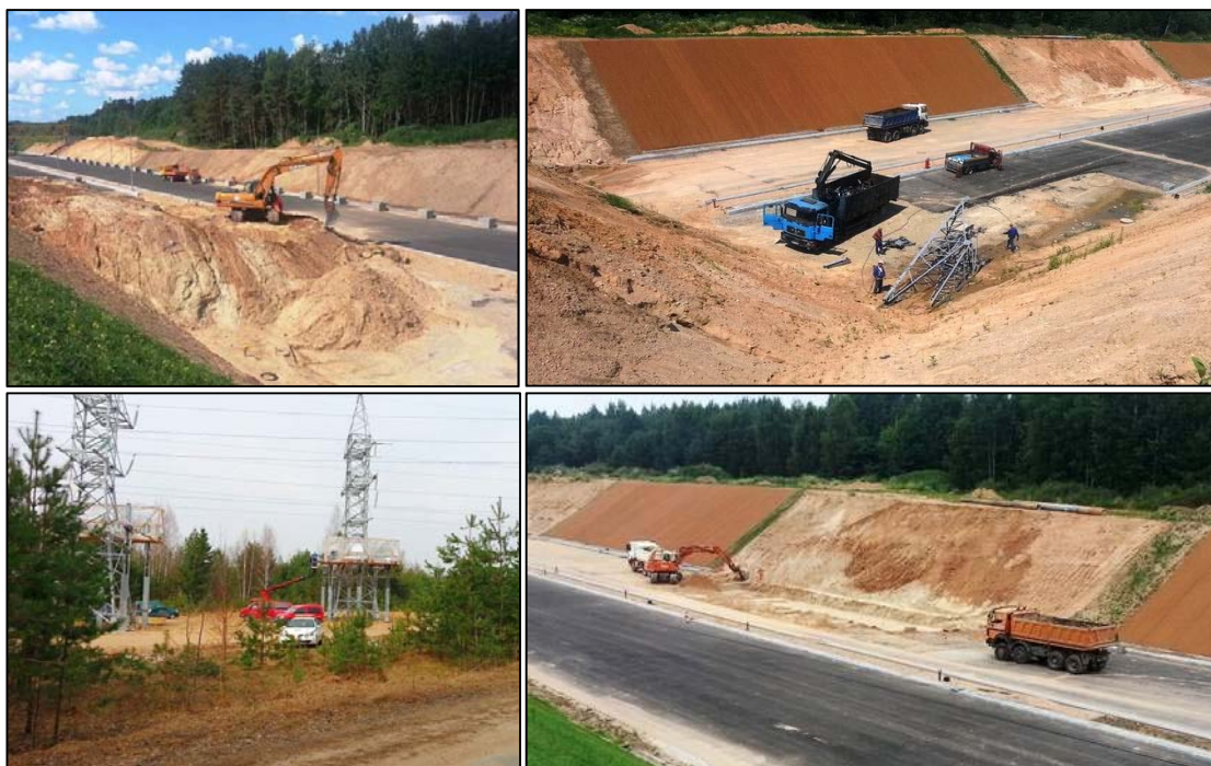
2.13 pav. Elektros atramų išmontavimo bei šlaitų tvarkymo darbai (Vakarinio... 2014)
