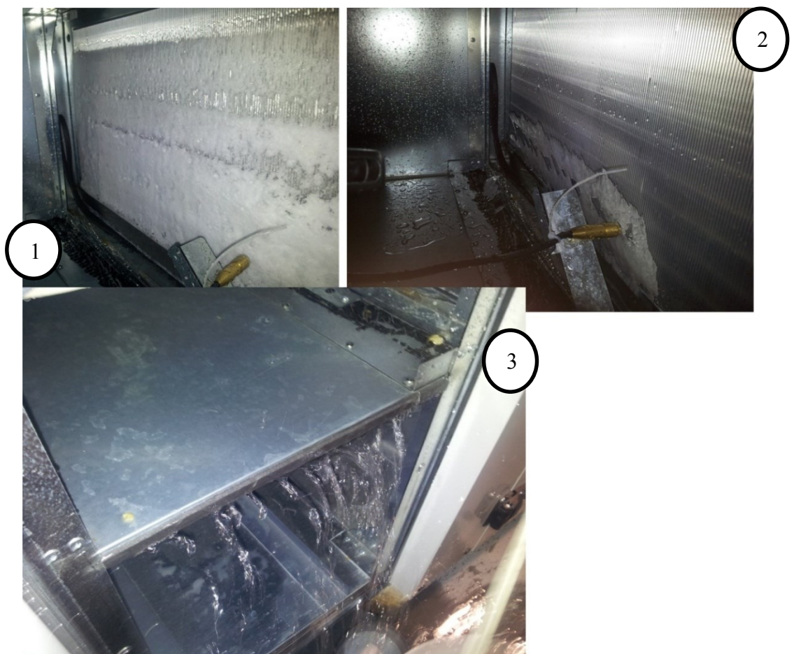
43 pav. Uždelsto apšalimo atitirpinimo anomalijos vedinimo įrenginyje
