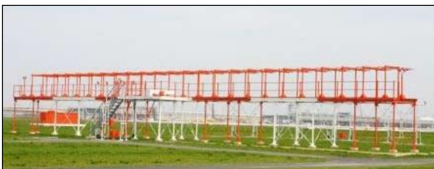
6 pav. Krypties radijo švyturio antenų sistema
