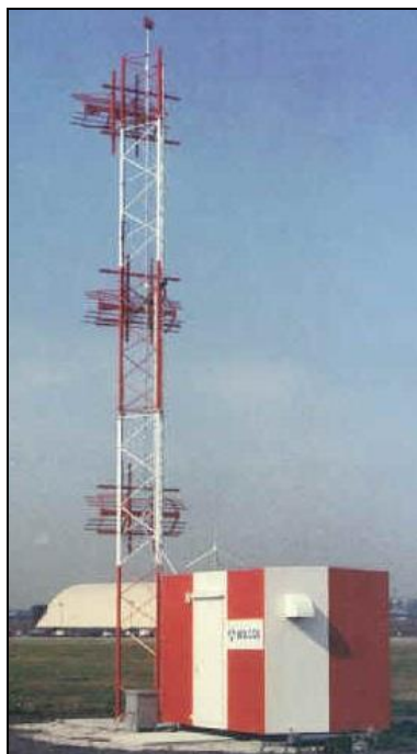
8 pav. Krypties radijo švyturio antena
