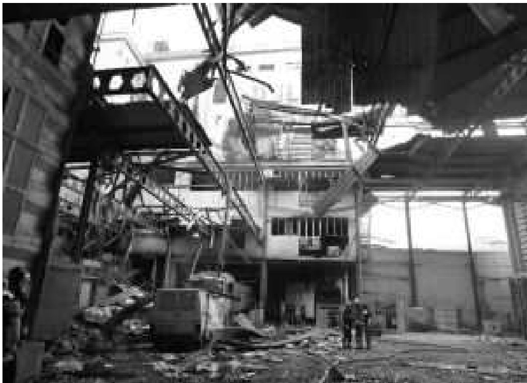
16 pav. Pastato nuotrauka po tiesioginio žaibo smūgio (pastate nebuvo sumontuota žaibosauga)
