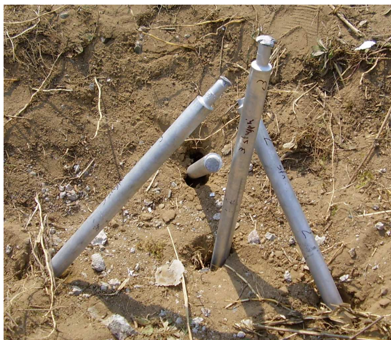
62 pav. 4 įžeminimo strypai, iš kurių 3 sukalti 45° kampu į gruntą
