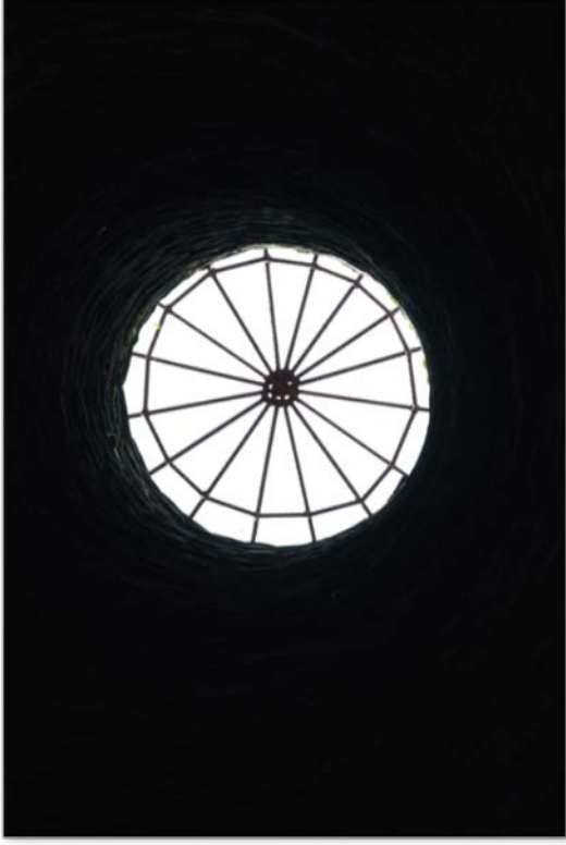
14 pav. Uždengta vėdinimo anga.
