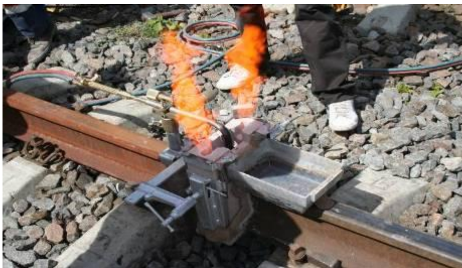
2.2 pav. Keraminių formų uždėjimas ant bėgių tarpo ir bėgių galų šildymas
