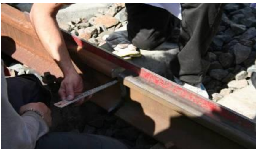
2.1 pav. Bėgių horizontalios plokštumos ir tarpo tarp bėgių nustatymas
