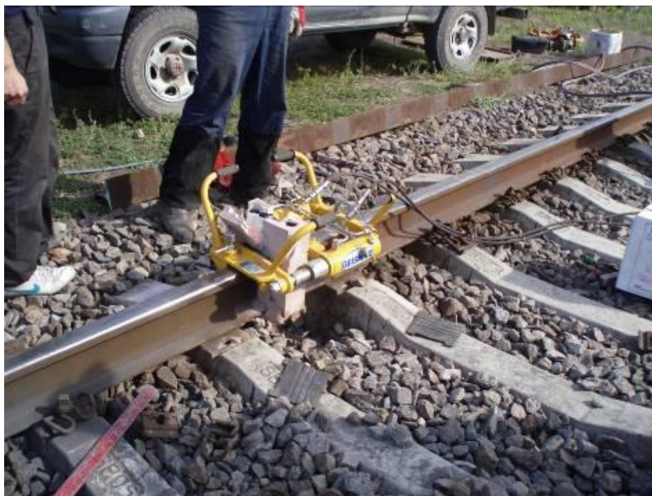
2.6 pav. Mechaniniu būdu nuo bėgio galvutės pašalinamos metalo užlajos ir šlakas
