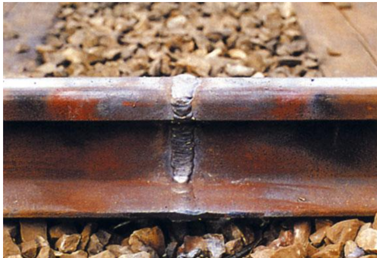
2.11 pav. Bėgių sujungimas, naudojant elektrodus OK 83.28 ir OK 74.78 bei keraminį padėkliuką OK Backing 21.21
