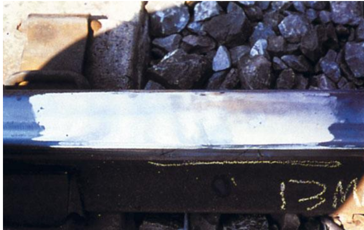
2.12 pav. Bėgio aplydymas su OK 74.78 ir OK 83.28 arba milteline viela OK 15.43
