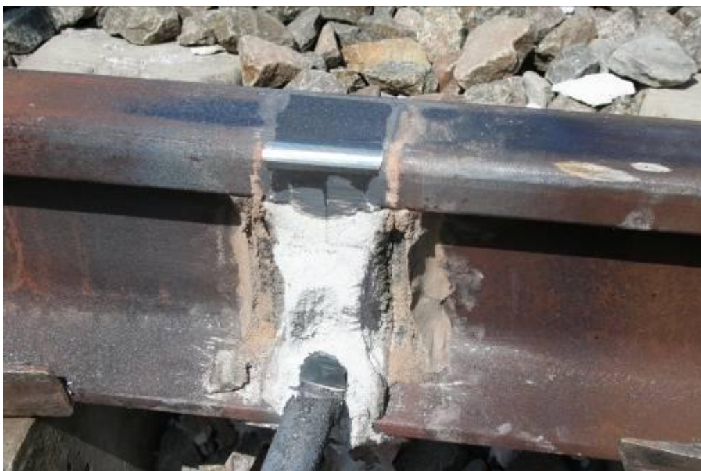
1.1 pav. Termitiniu būdu suvirintų bėgių jungtis
