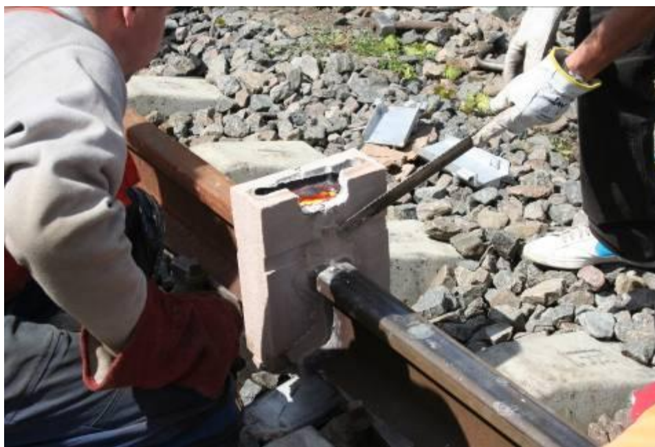
2.5 pav. Keraminių formų nuėmimas
