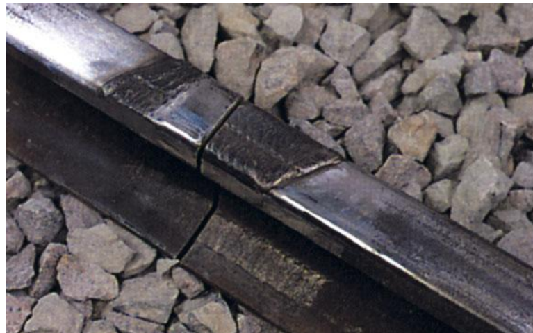
2.13 pav. Bėgių galų remontas - elektrodais OK 74.78 ir OK 83.28, miltelinė viela OK 15.43
