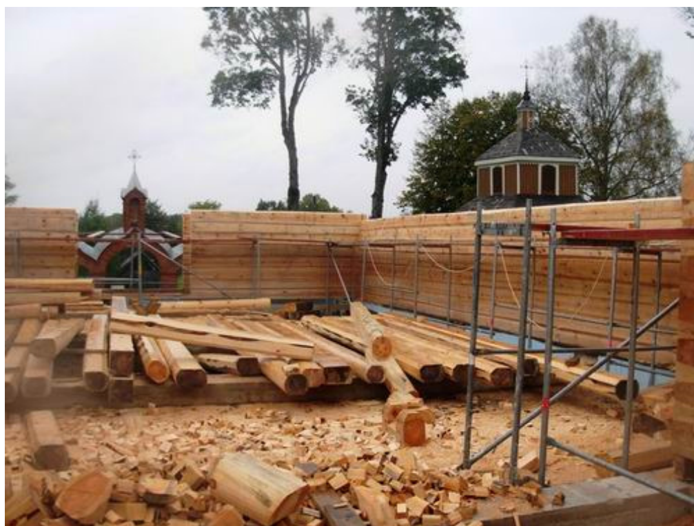
3.9 pav. Labanoro bažnyčios atstatymo darbai ( Labanoras... 2010)
