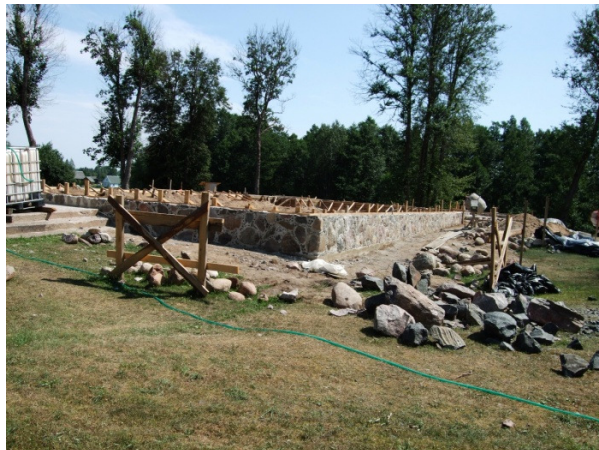
3 pav. Atstatomos Labanoro bažnyčios pamatai, B. Panumienės nuotr. 2009 m.
