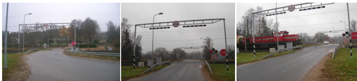
7 pav. Pervaža (PK 4+633) Pavilnio gatvėje su gabarito vartais ir automatinės signalizacijos įrenginiais
