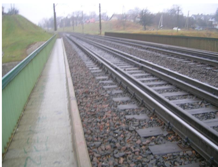
13 pav. Bėgiai ir gretbėgiai ant G/b tilto PK 1+389 (susikirtimas su Sukilėlių g.)
