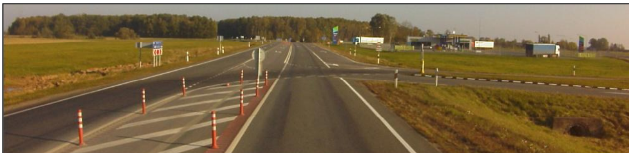
4.7 pav. Frezuota saugumo salelė su lanksčiais stulpeliais kelyje A10 Panevėžys–Pasvalys–Ryga 46,500 km
