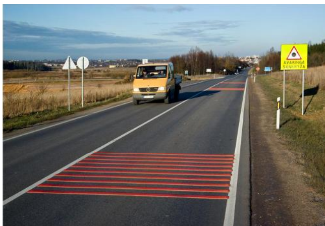
2.5 pav. Skersinio struktūrinio ženklinimo triukšmo juosta ir kelio ženklas „Juodoji dėmė“
